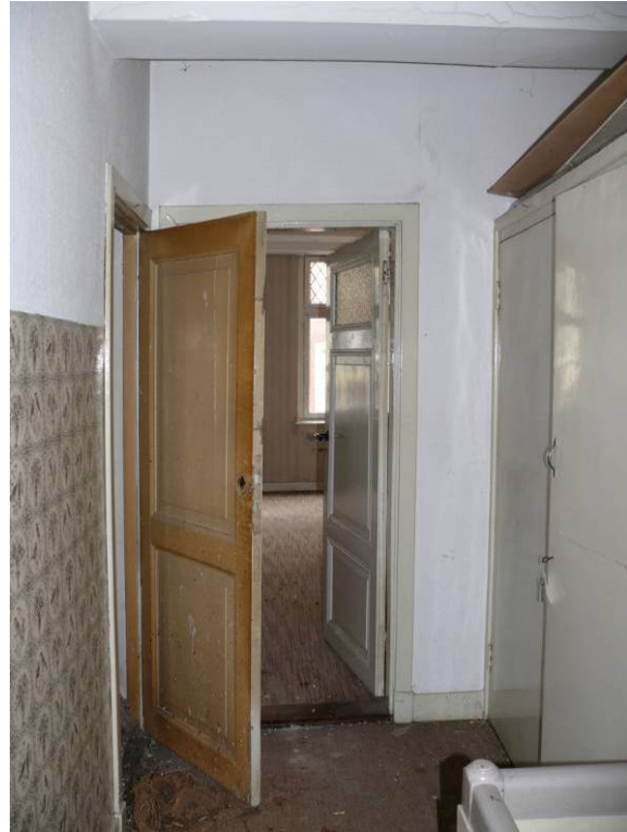
92 Paneeldeuren op de tweede verdieping
