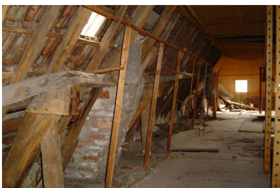
Kapconstructie naar achteren, doorgezaagde jukken
