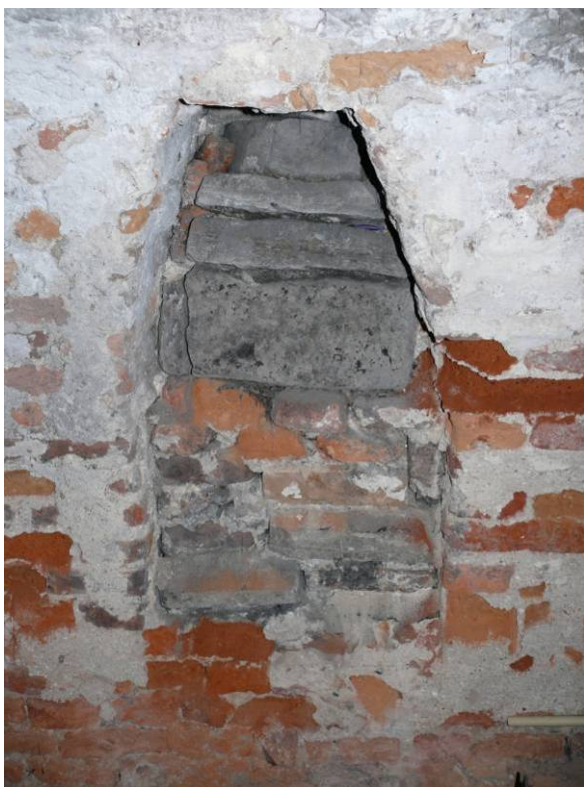
31 dichtgezet schouwttje in de voorkelder
