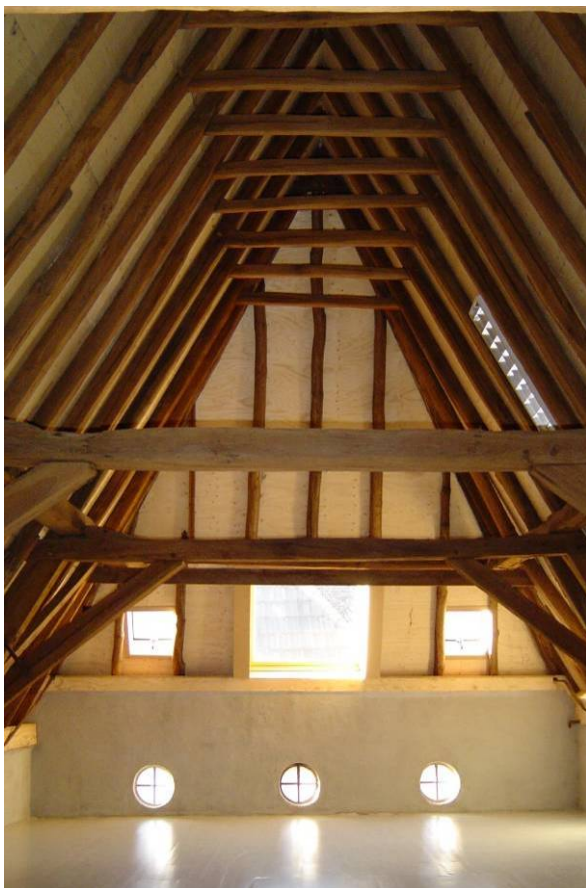
De sporenkap richting de voorgevel
