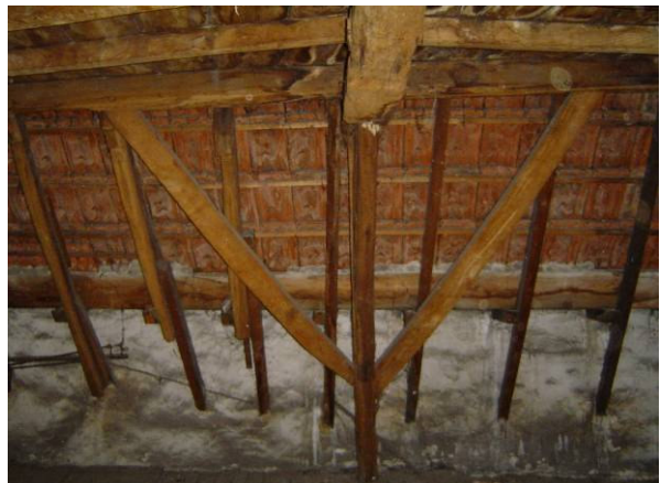
Spantbeen met windschoren, zuidzijde
