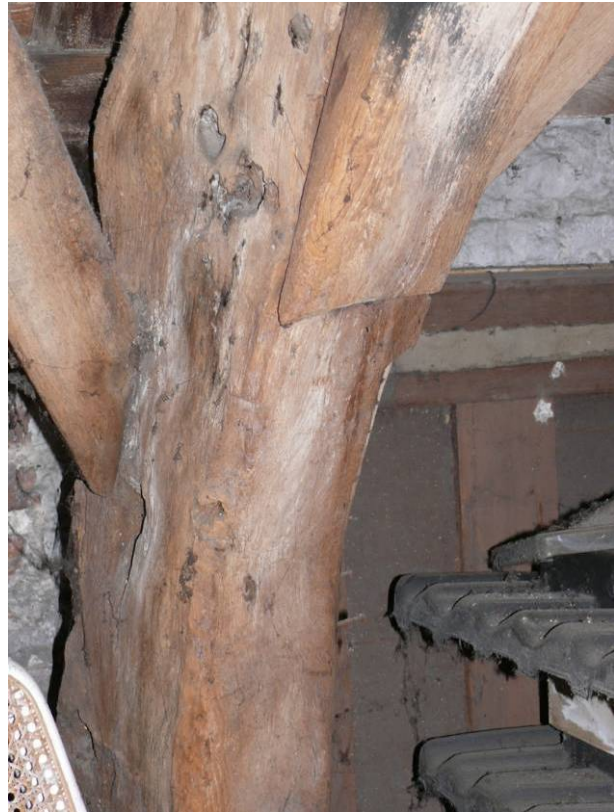
Gotische kapellen aan de onderste spantbenen
