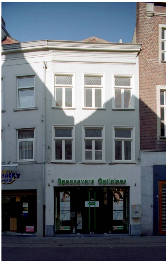
87 De voorgevel van Vleesstraat 18
