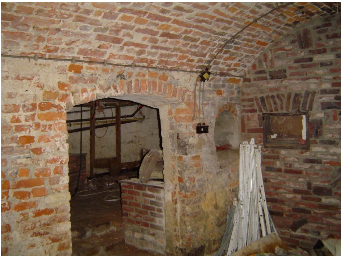
100 De doorgang tussen beide kelders, gezien vanaf de zuidelijke kelder van Vleesstraat 19
