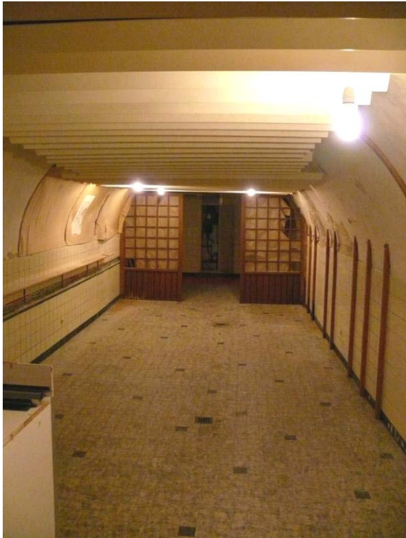
27 de kelder onder nr.7 richting de voorgevel
