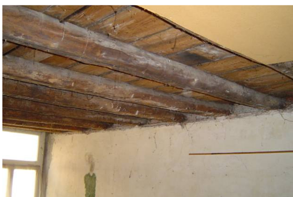
Grenen balklaag eerste verdieping nr.4
