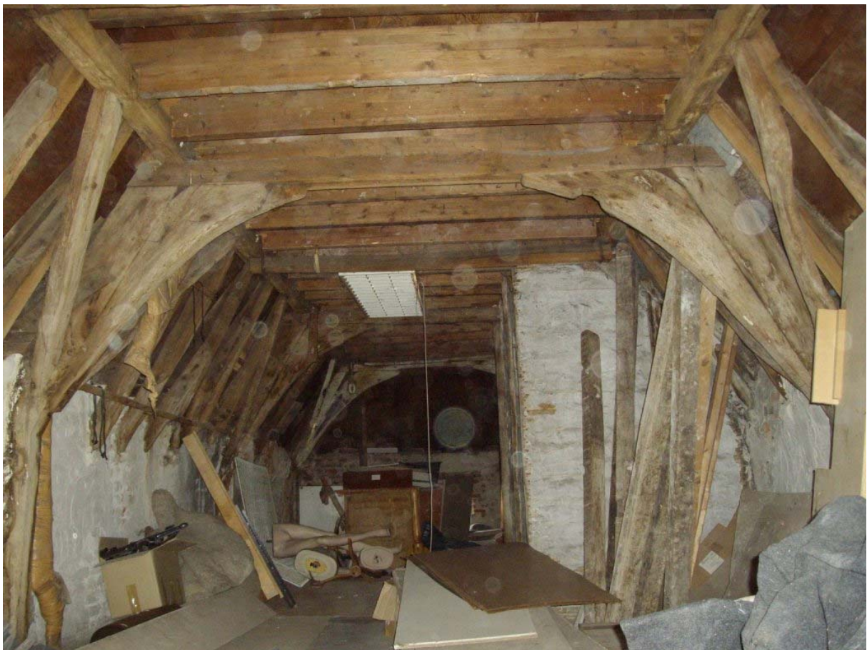
Overzicht van de kapconstructie richting de voorgevel met rechts de trapombouw
