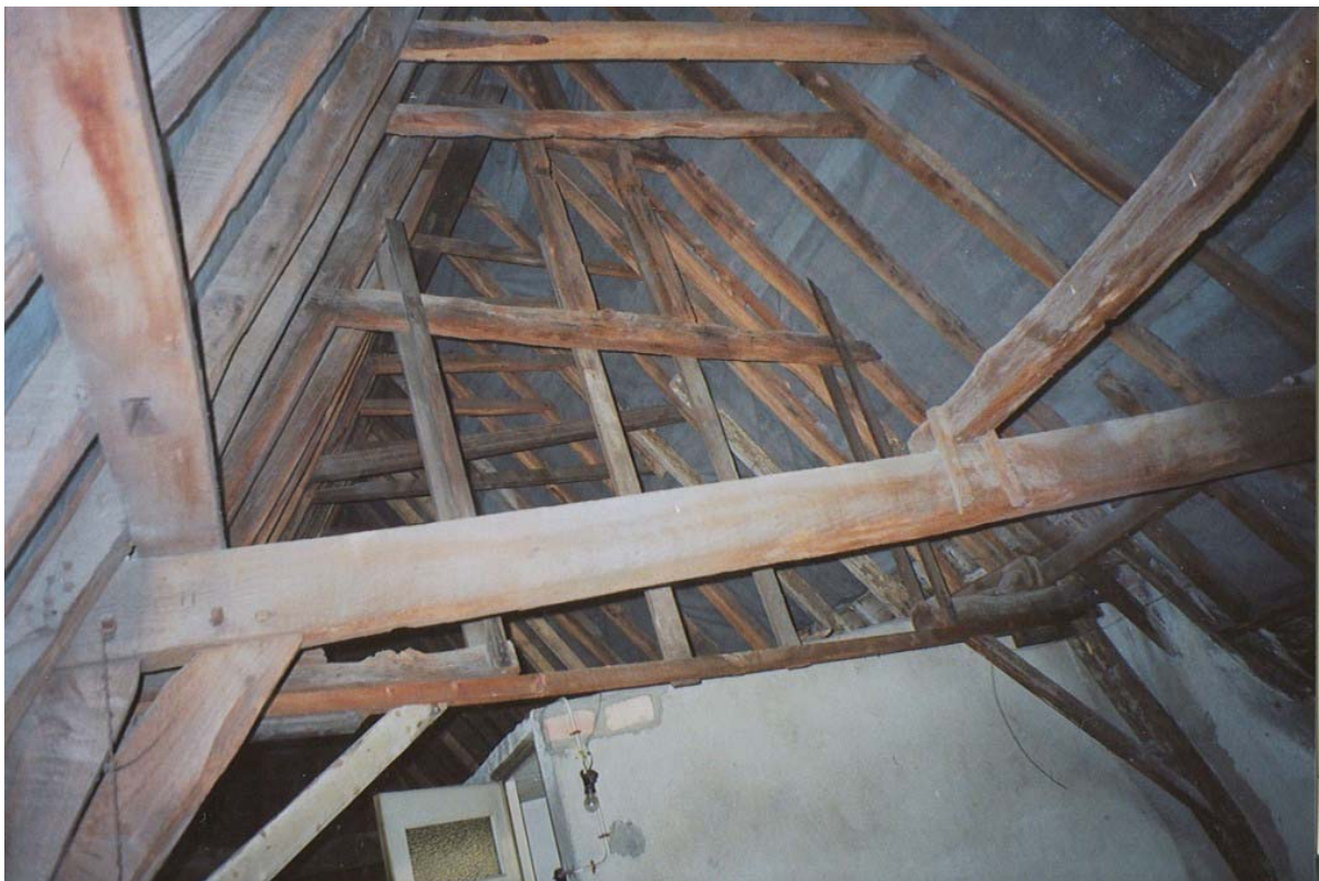
119 Houten vakwerkspant dat als tijdelijke afdichting van de kapruimte heeft gediend, bij de verlenging in 1649
