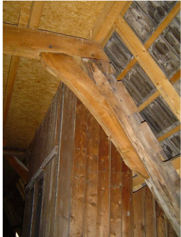
102 Kapconstructie; een moerbalk hergebruikt als spantbeen
