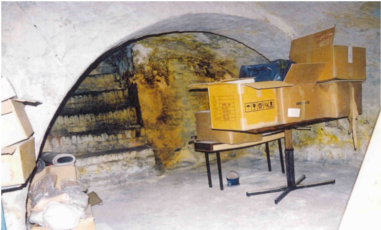
130 De uitbouw aan de achterzijde van de kelder met de bakstenen trap naar het achterterrein
