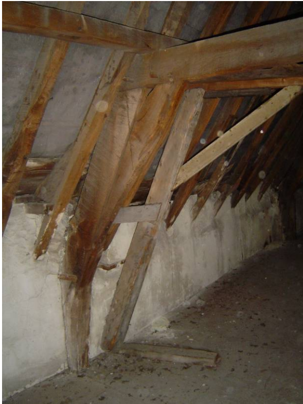
117 Het zuidelijke spantbeen van krommerspant // en het zuidelijke spantbeen van het vakwerkspant (rechts)
