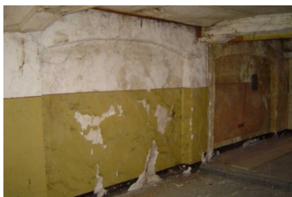
Spaarbogen zijmuur tweede verdieping nr.4
