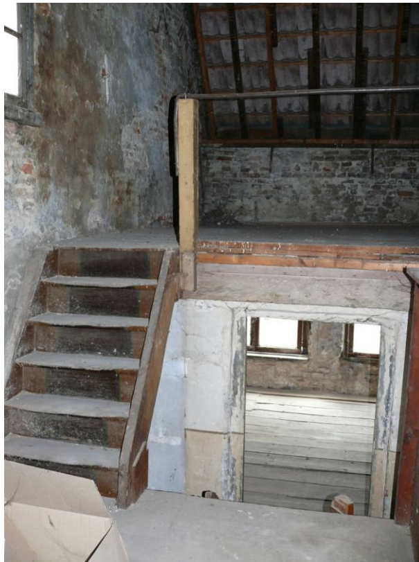
13 opkamer aan de achterzijde van de derde verdieping
