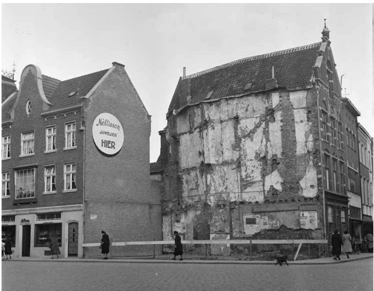
Foto J hoek Markt – Gasthuisstraat omstreeks 1950. in de zijgevel van Gasthuisstraat 1 tekenen zich de balkgaten af van de middeleeuwse balklagen van het afgebroken hoekpand Markt 1
