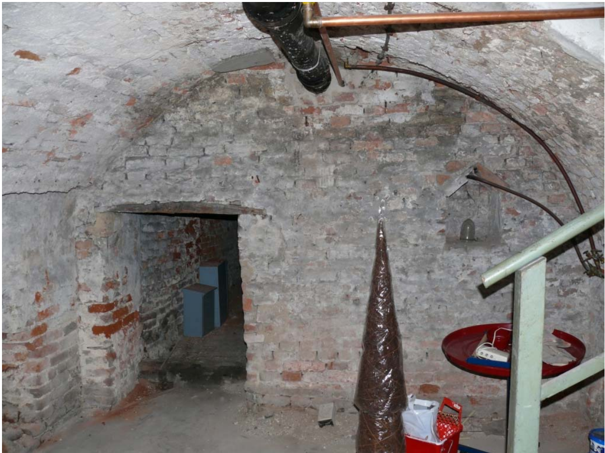
30 de achtergevel van de voorkelder met links de doorgang naar de achterkelder en rechts een kaarsnis
