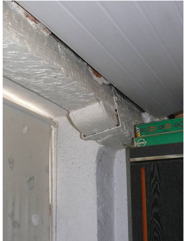
Voorste strijk balk met slof op de tweede verdieping
