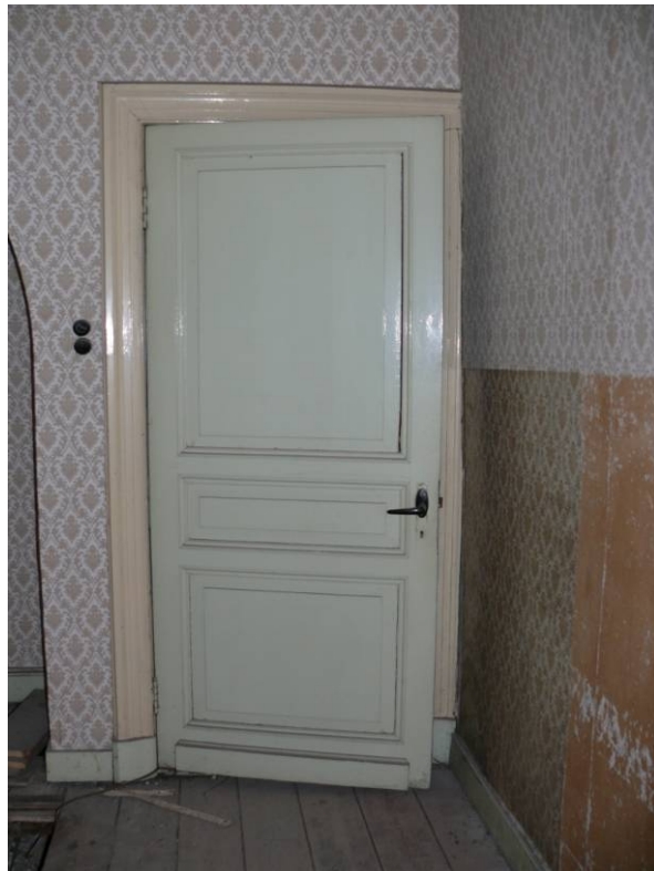
53 Paneeldeur op de eerste verdieping
