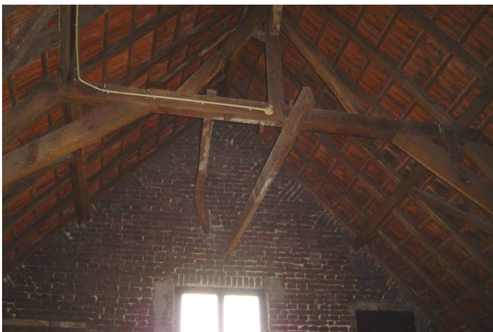
Laatste kaspant en achtergevel
