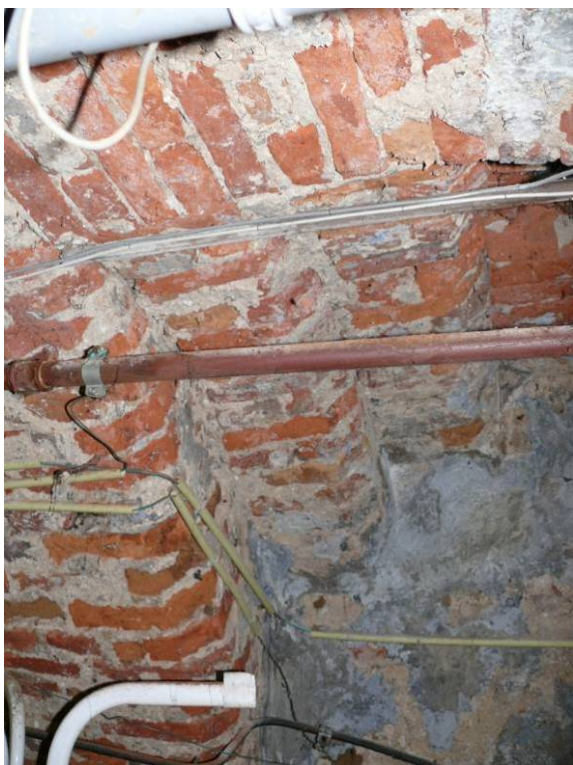
7 trapsgewijs gewelf boven de oorspronkelijke toegang
