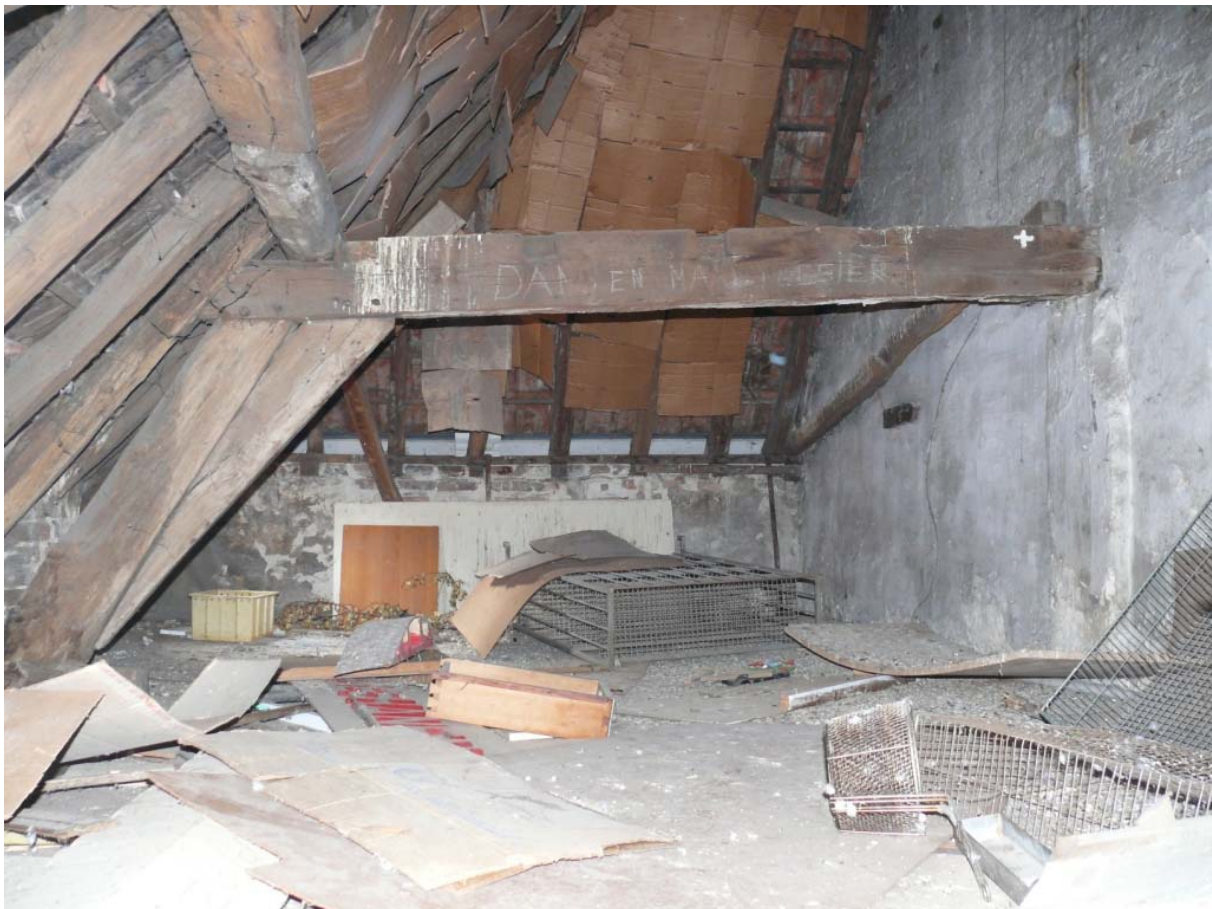
112 Overzicht van de kap richting voorgevel met het voorste, ingekorte, halve krommerspant
