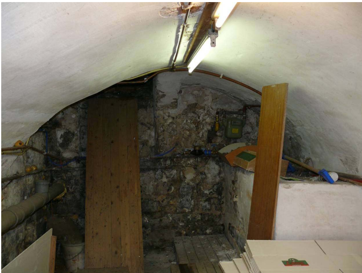
151 De voorkelder richting voorgevel (XV-XVI)
