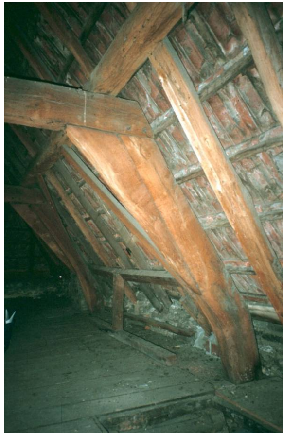
143 Eiken krommerspantbeen van de kapconstructie
