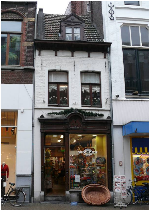
149 De voorgevel van Vleesstraat 45
