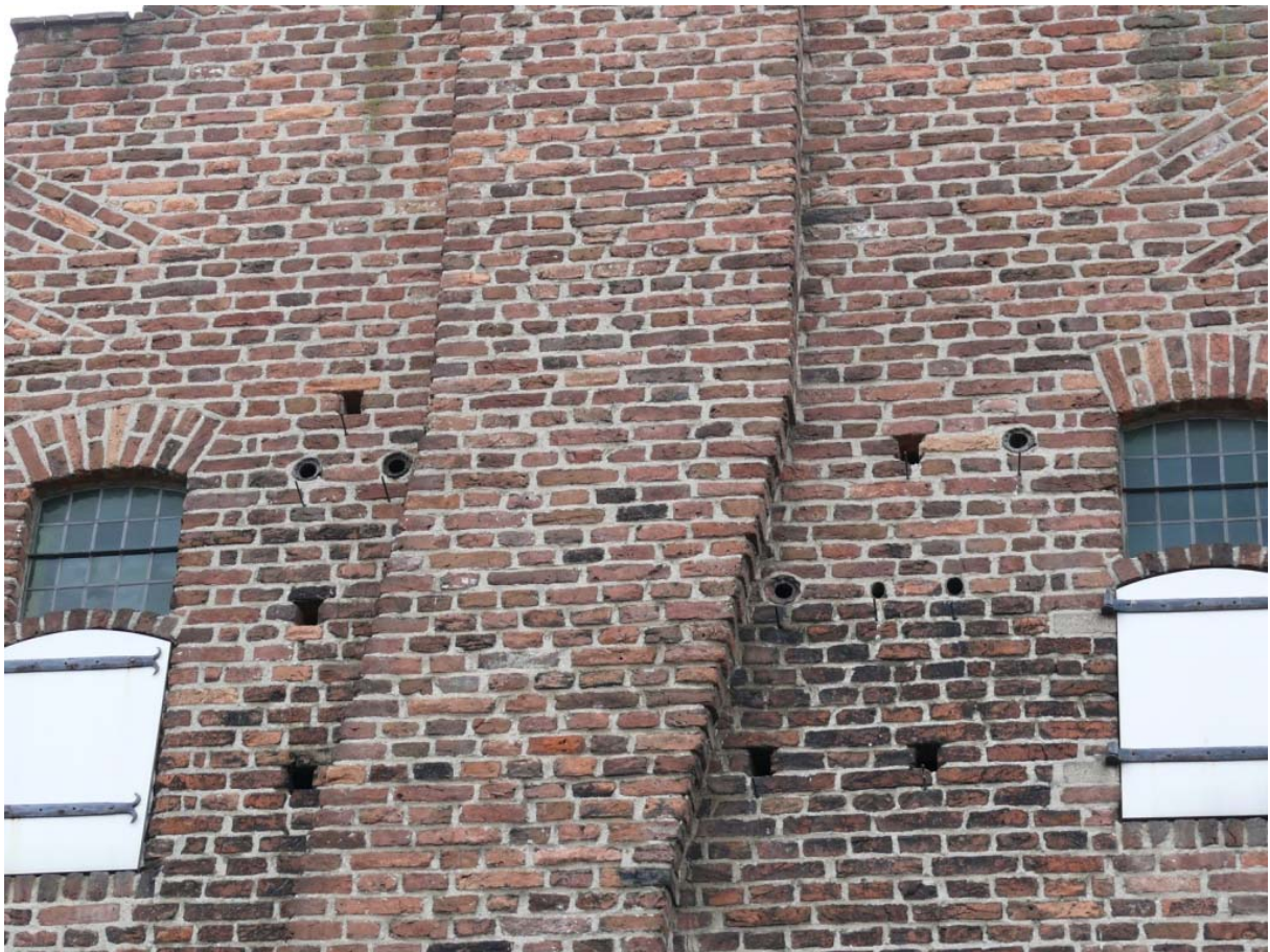
42 De achtergevel van Vleesstraat 7-9 ter hoogte van de zolder met originele vogelgaten (spreeuwpotten)
