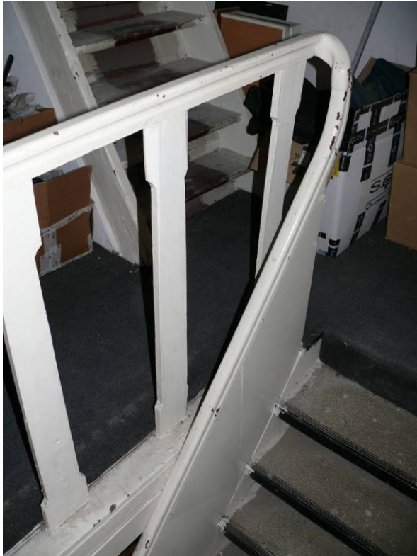
Vroegnegentiende-eeuwse balustertrap op 2 e verdieping
