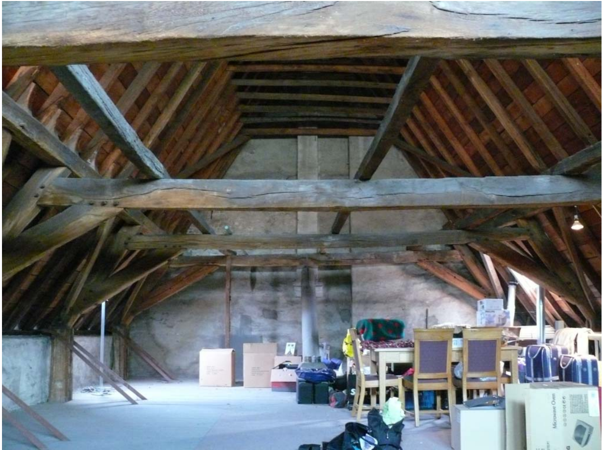
35 de kapconstructie van Vleesstraat 7-9, richting de achtergevel van het voorhuis
