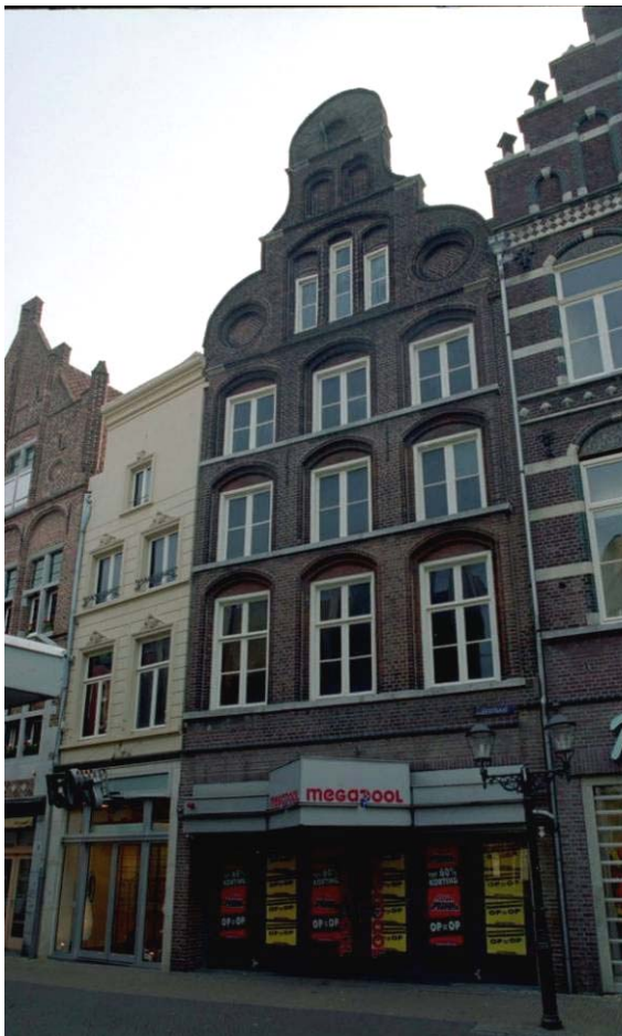
61 De voorgevel van Vleesstraat 13
