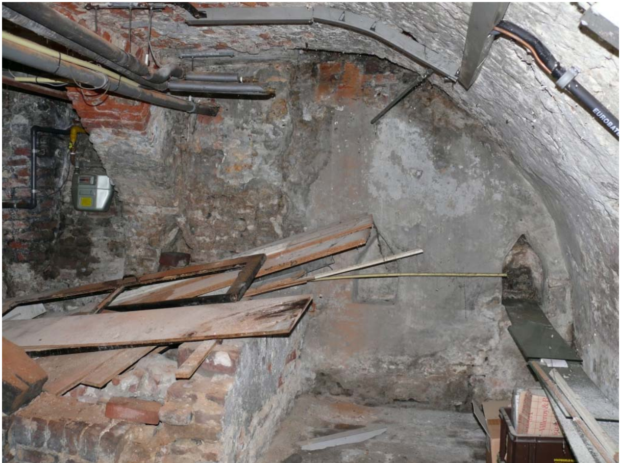
6 voorgevel van de voorkelder, met drie middeleeuwse kaarsnissen. Links de oorspronkelijke toegang
