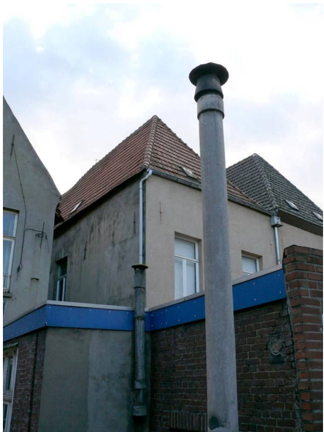
de gecementeerde achtergevel
