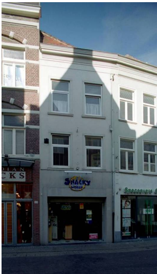
108 De voorgevel van Vleesstraat 20
