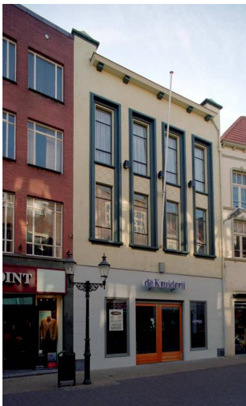
97 De voorgevel van Vleesstraat 19
