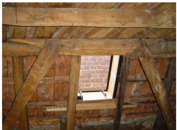
Verbindingsstuk voorste en achterste gording, zuidzijde
