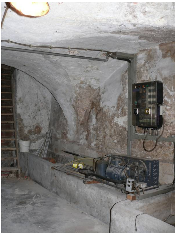
Het kruisgewelf van de achterkelder
