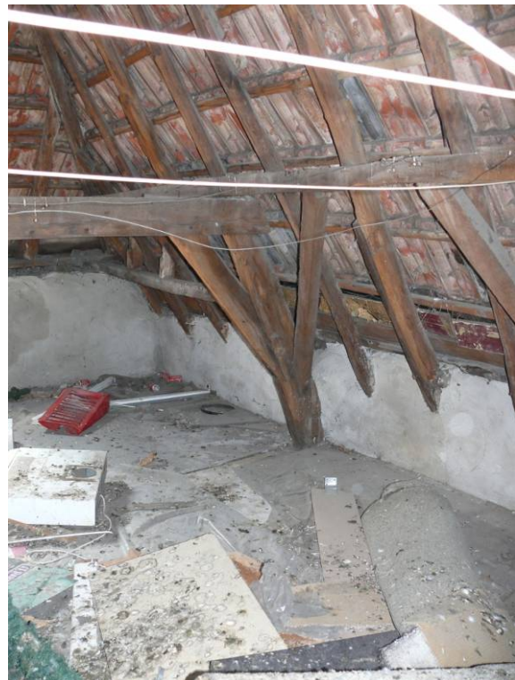
94 Ingekort spantbeen van een krommerspant
