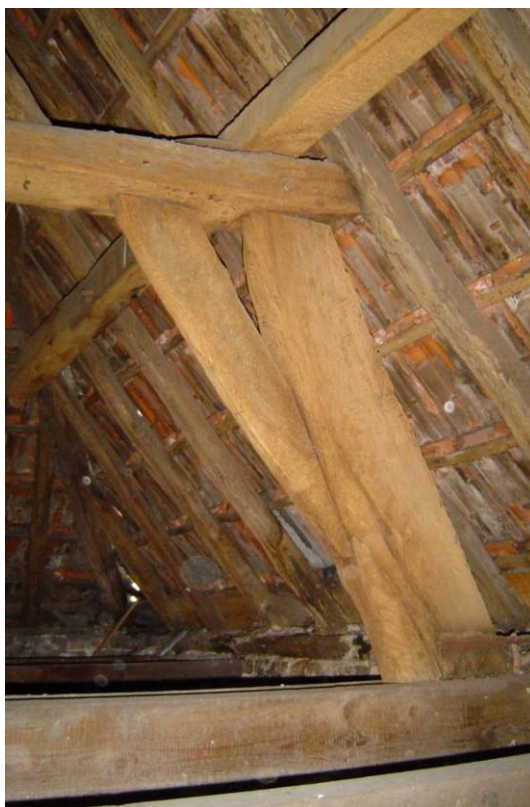
Eiken spantbeen van een middeleeuws kapspant
