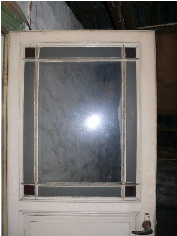
80 Een laatnegentiende-eeuwse paneeldeur met glas-in-lood op zolderniveau
