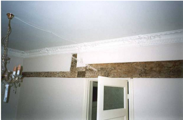
Moerbalk voorkamer eerste verdieping met verlenging
