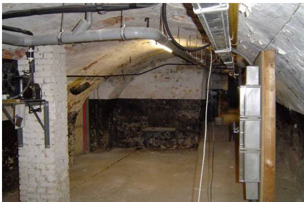
Kelder nr. 4 richting achtergevel
