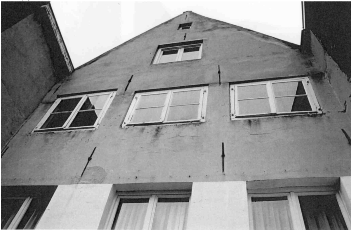
128 De achtergevel van Vleesstraat 23 boven de begane grond
