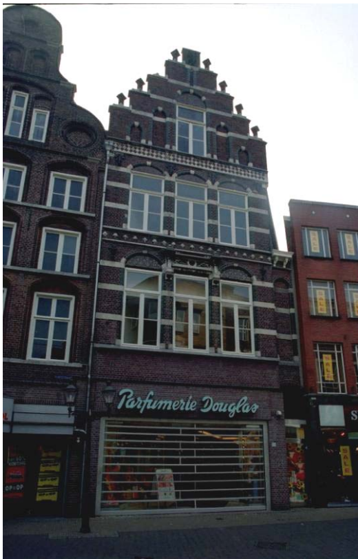
73 De voorgevel van Vleesstraat 15
