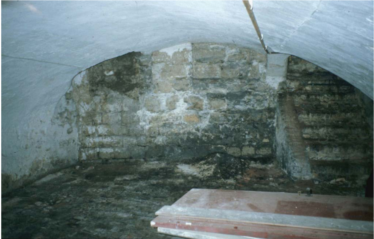
129 De kelder van Vleesstraat 23 richting de voorgevel met rechts de oorspronkelijke toegang met trap
