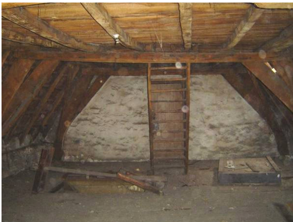
Kapconstructie richting tussenwand
