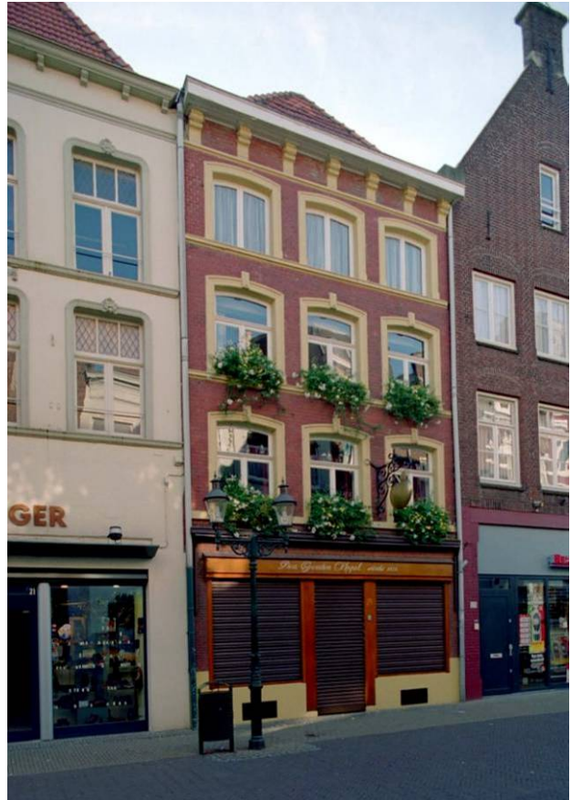
127 De voorgevel van Vleesstraat 23
