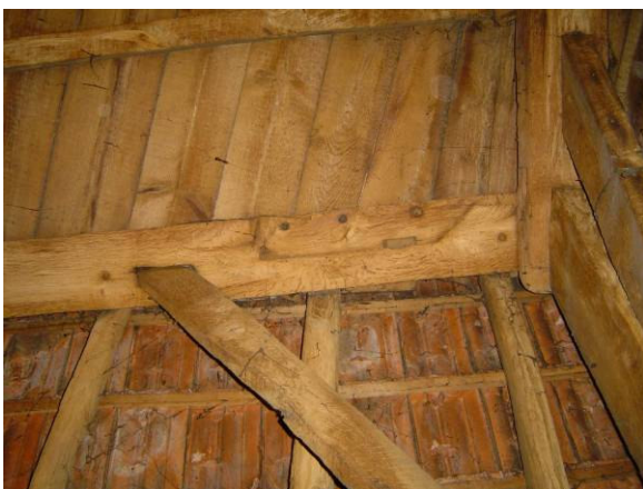
Hergebruikte, gespleten balk uit vakwerkconstructie
