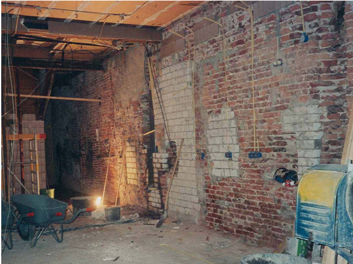
Scheidingsmuur tussen nr.3 en nr.5 tijdens werkzaamheden in 1978. In de muur werd, behalve sporen van een muurnis en een haardpartij ook een ontlastingsboog van een oorspronkelijke deuropening tussen beide panden aangetroffen, wat erop duidt dat ze als eenheid zijn gebouwd. (foto fam. Schreinemachers)
