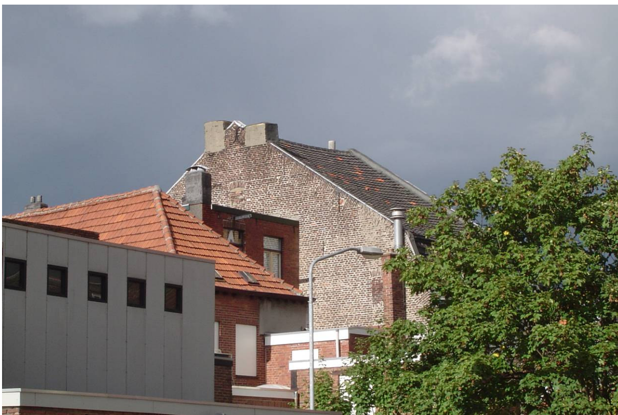
Zicht op de zijgevel van nr.36 (rechts) en het dak van nr.32 (midden) vanaf de Brouwersplaats
