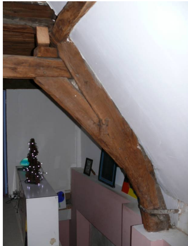
Eiken tussenbalkjuk op zolderniveau van het achterhuis
