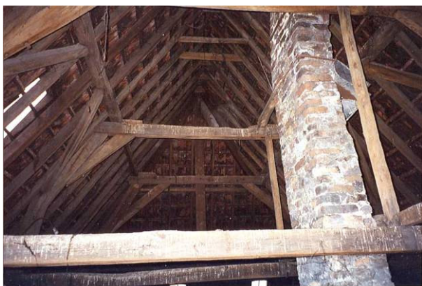
De kapconstructie boven zowel nr.4 als nr.6
