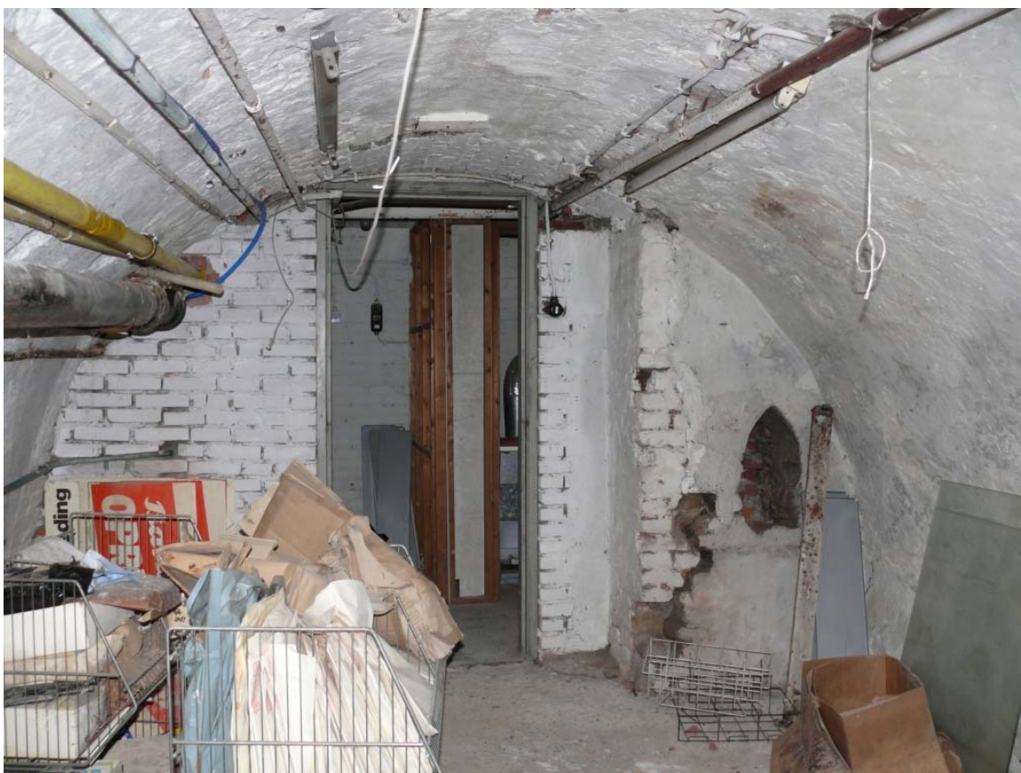
90 De in baksteen vervangen achtergevel van de kelder
