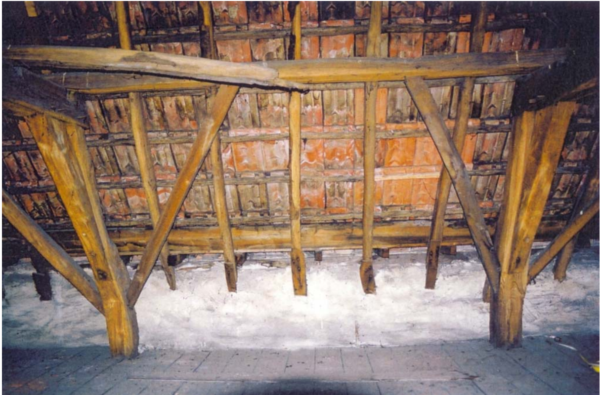
144 Eiken krommerspanten met windschoren van de kapconstructie
