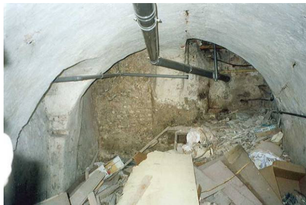
Kelder nr. 6 richting voorgevel
