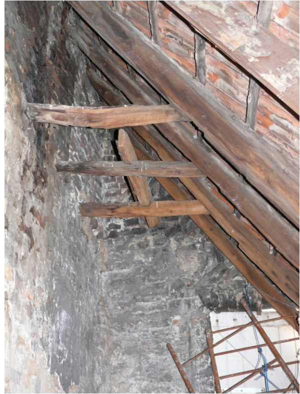
111 Daksporen en koppelingsbalkje bij de achtergevel
