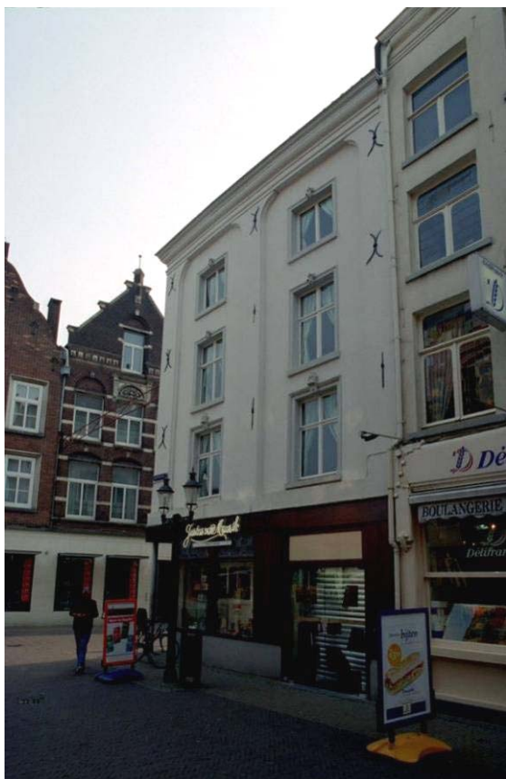
De gevel aan de Vleesstraat
