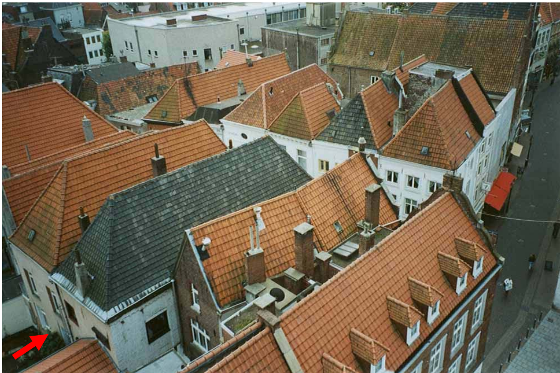
Luchtfoto van de Gasthuisstraat met de 'tweelingpanden' Gasthuisstraat 3 en 5 bij de pijl
