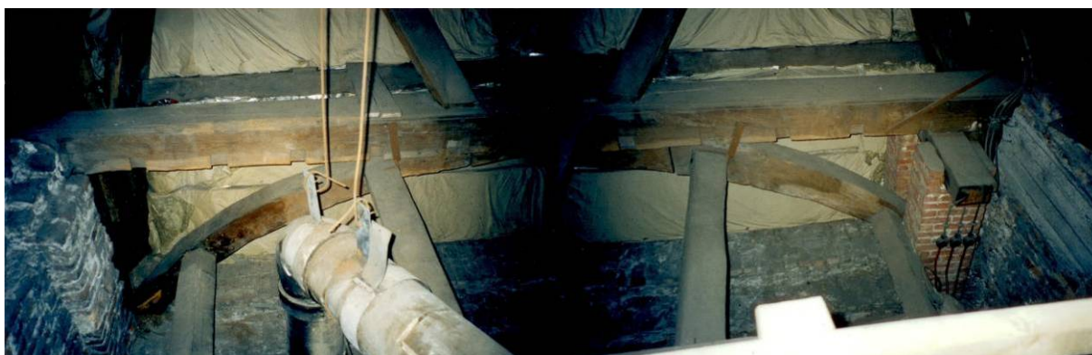
Trekbal boven het schip van de kapel, bij de aansluiting met het koor, eronder de eiken boog van het verdwenen achttiende-eeuwse tongewelf
