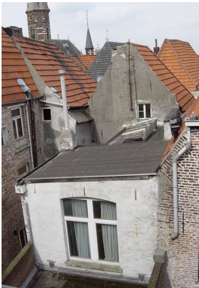
De achtergevel en achterbouw van Gasthuisstraat 8
