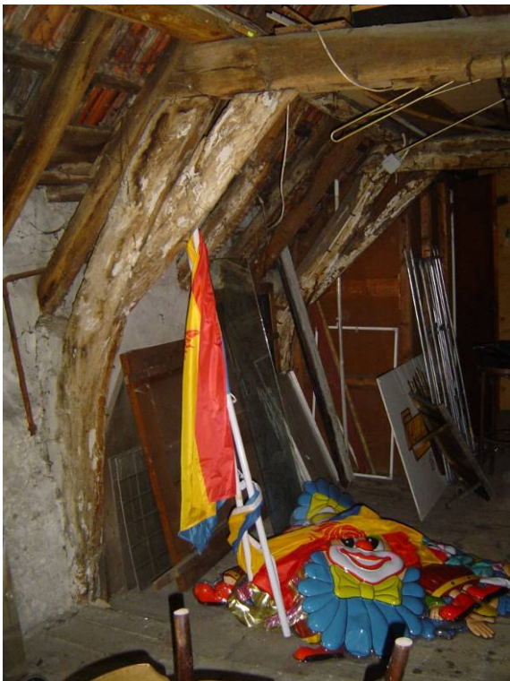
Kapconstructie aan voorzijde (noordelijke spanten)
