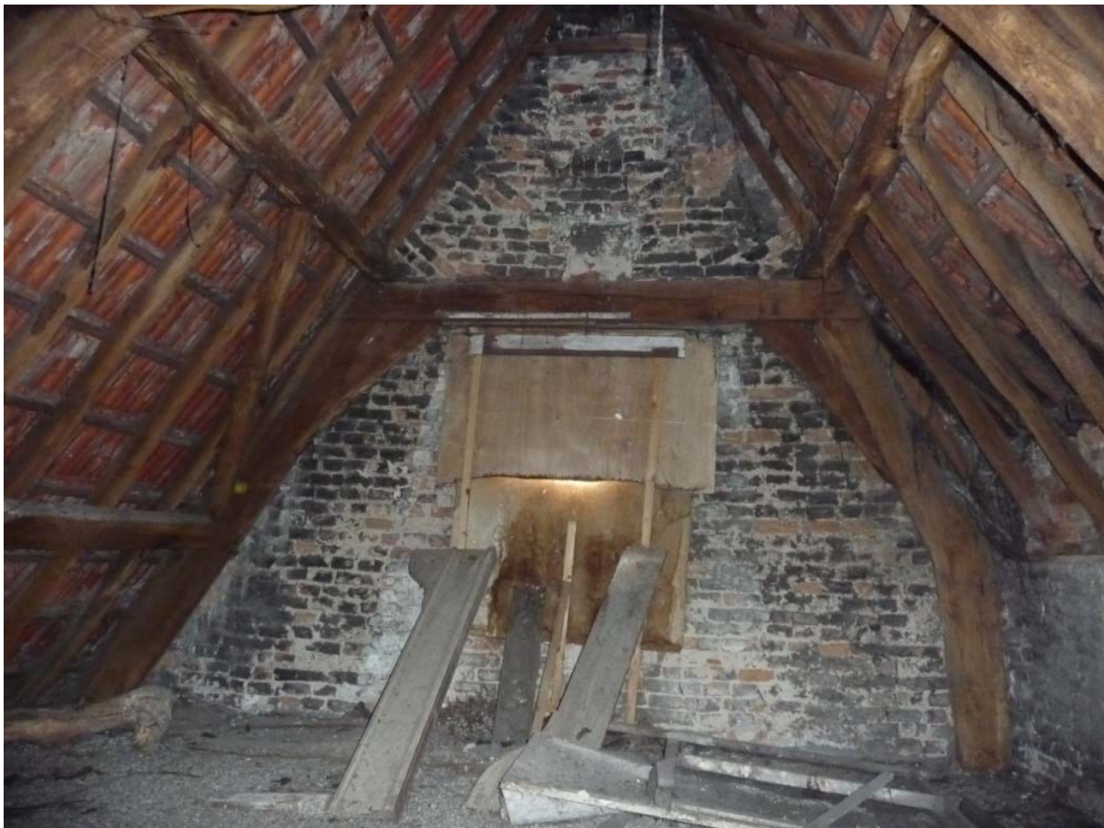
Achterste strijkspant tegen de achtergevel met schuine stijl en ingepende tussengording links en kromstijl rechts
