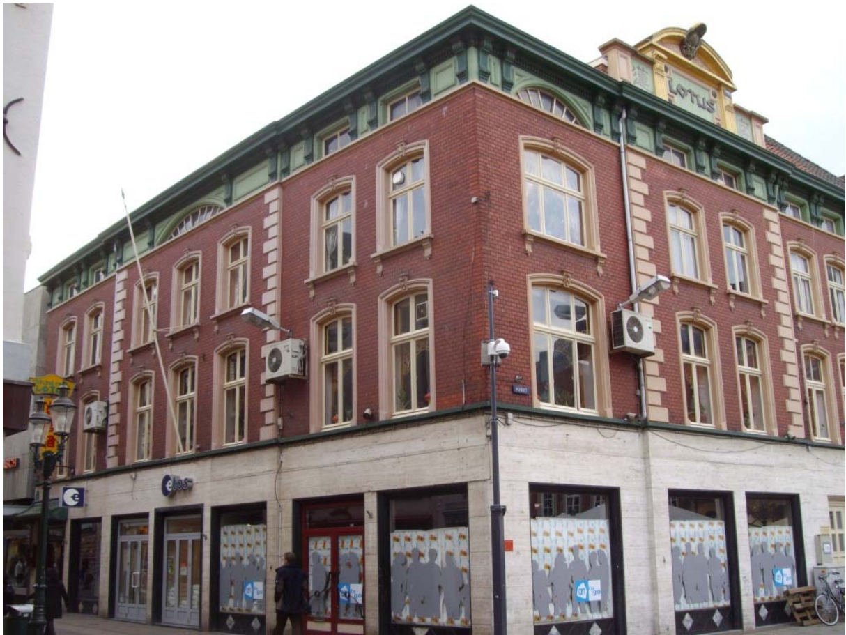
18 de gevel aan de Vleesstraat
