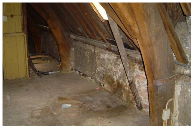
Zoldervloer en borstwering
