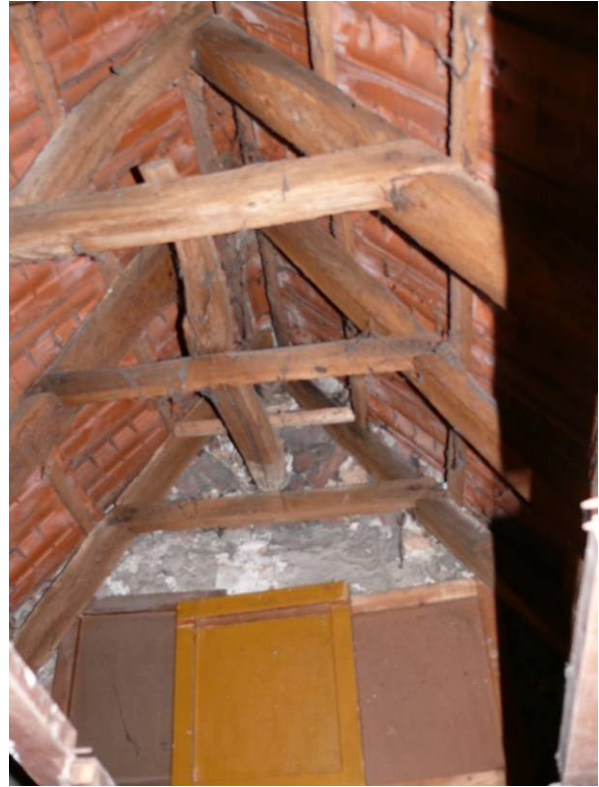
Koppelbalkje tussen de haanhouten en de achtergevel
