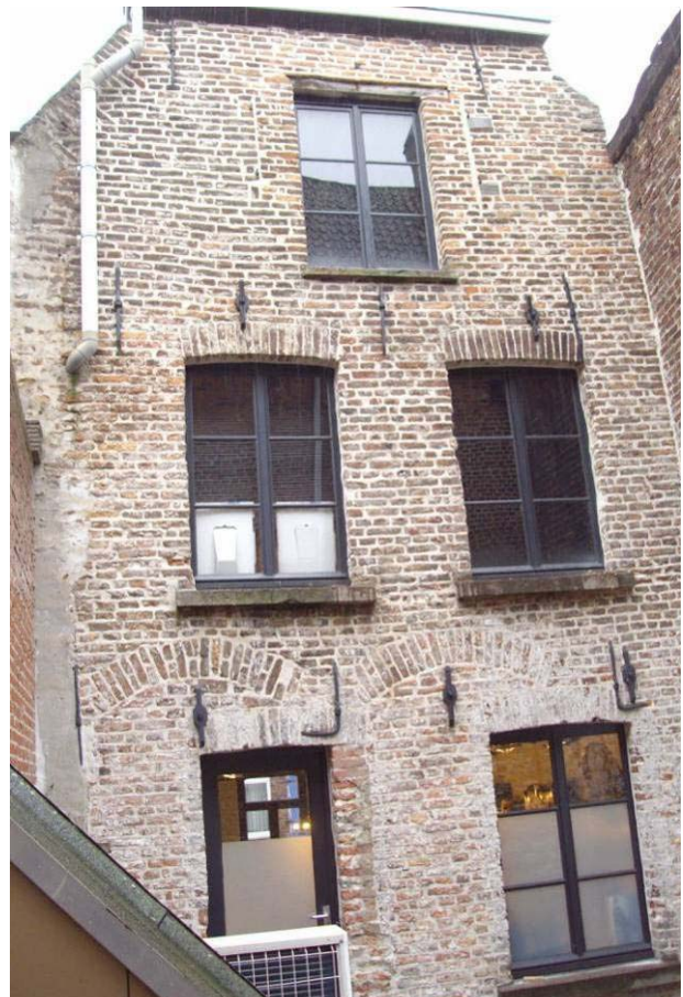
De achtergevel met bouwsporen van Gasthuisstraat 10
