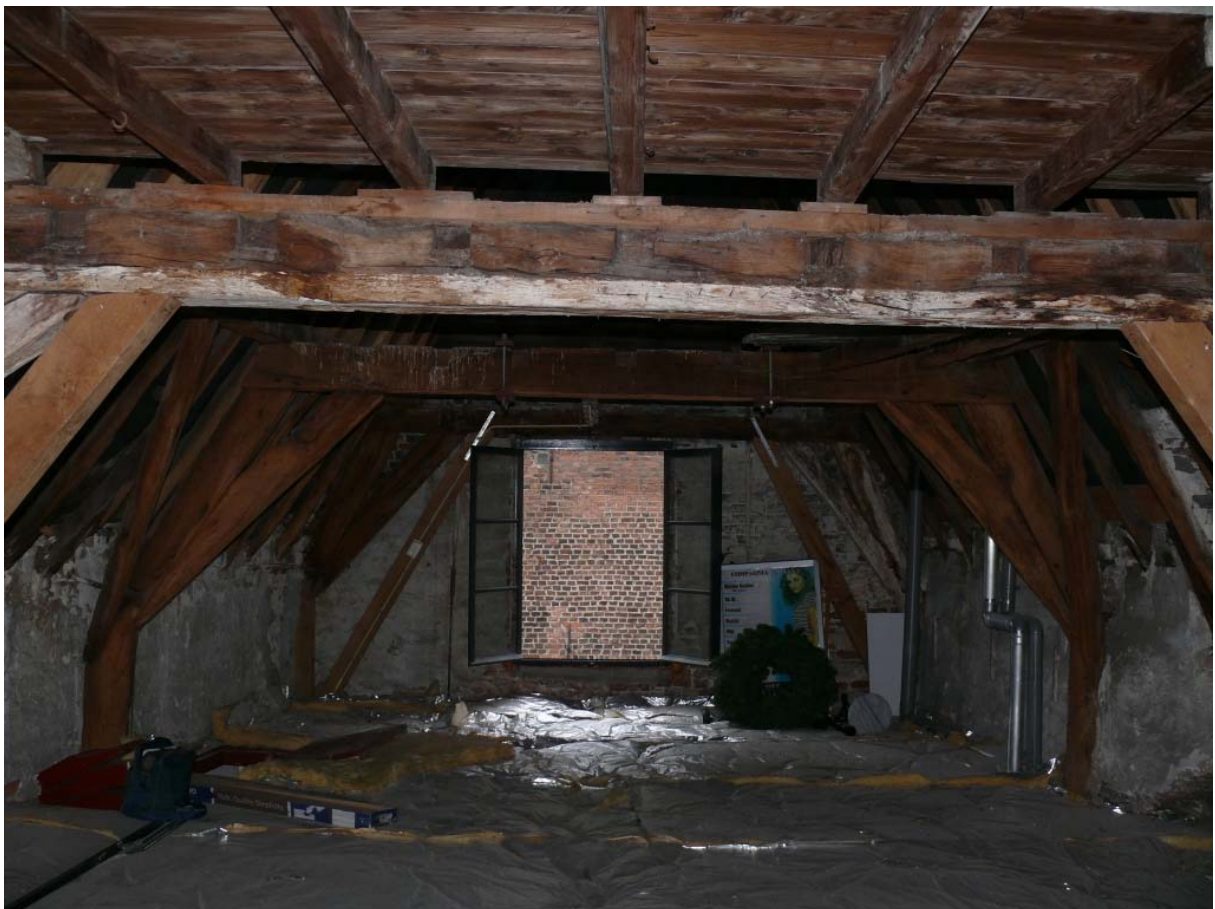
De kapconstructie van Gasthuisstraat 10 richting de achtergevel
