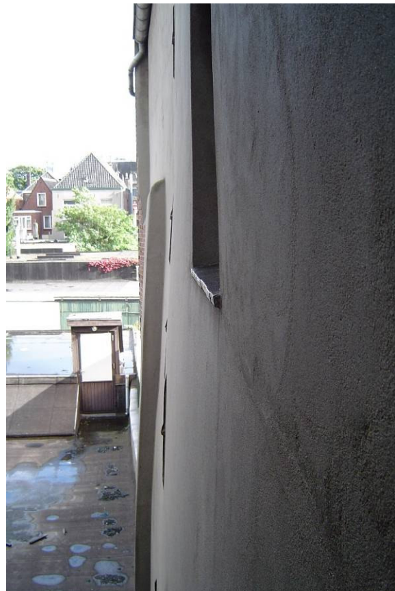
Middeleeuwse zijgevel, met gemetselde steunbeer
