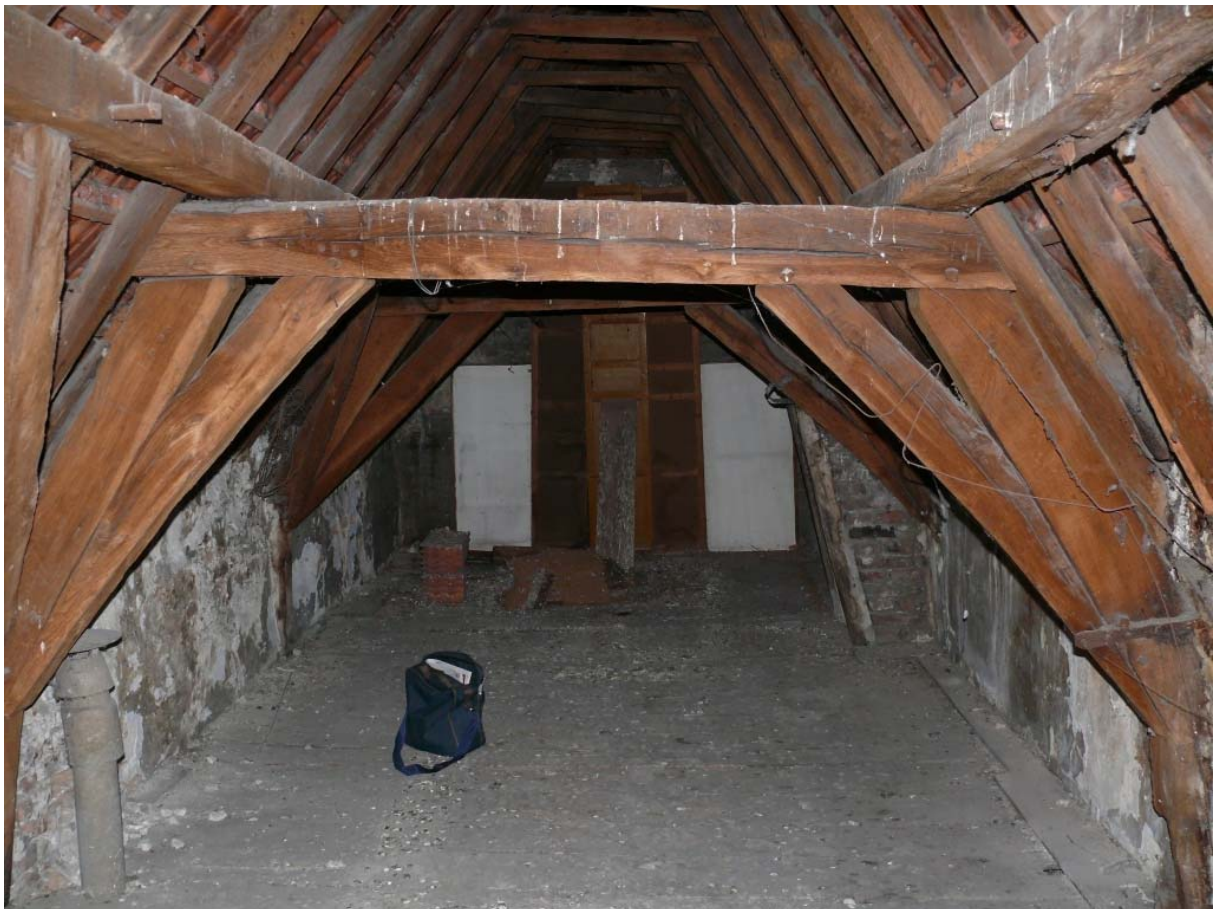
De laatmiddeleeuwse kapconstructie richting de achtergevel
