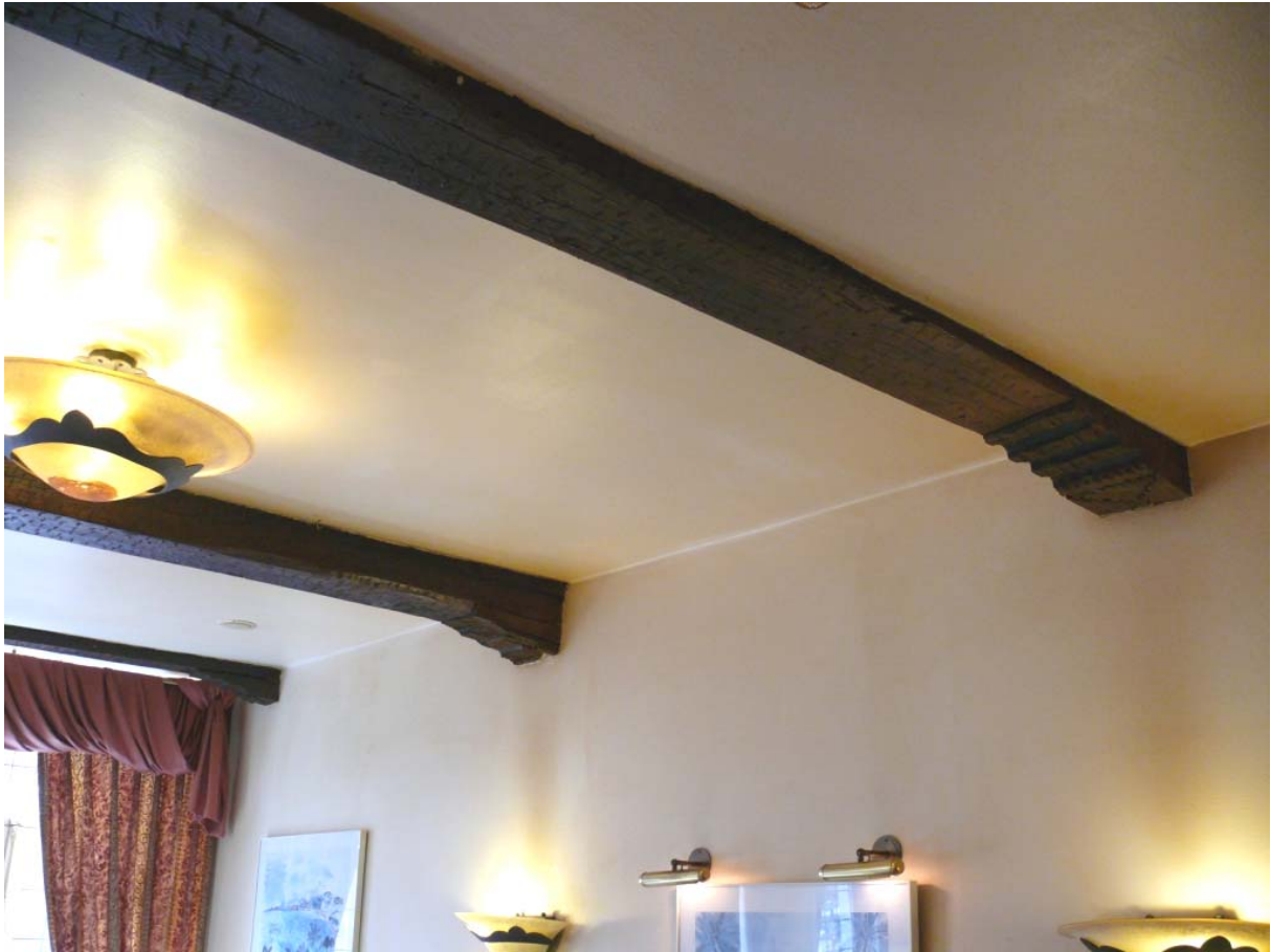
9 balklaag op de eerste verdieping. Eiken middeleeuwse balken met gedecoreerde sleutelstukken
