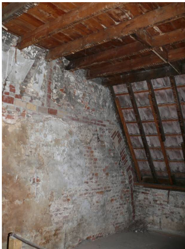
15 aftekening van een dakspant in de zuidelijke gevel
