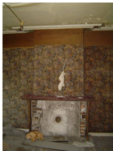
Schouw in de voorkamer van de eerste verdieping
