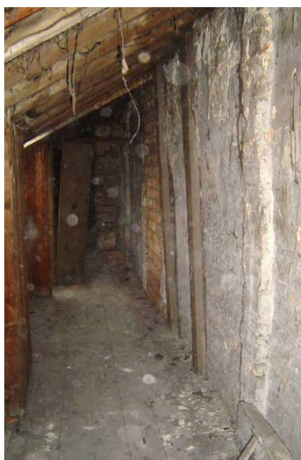
Kapconstructie met deelmuur dubbelpand rechts
