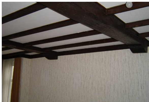
Balklaag voorkamer eerste verdieping
