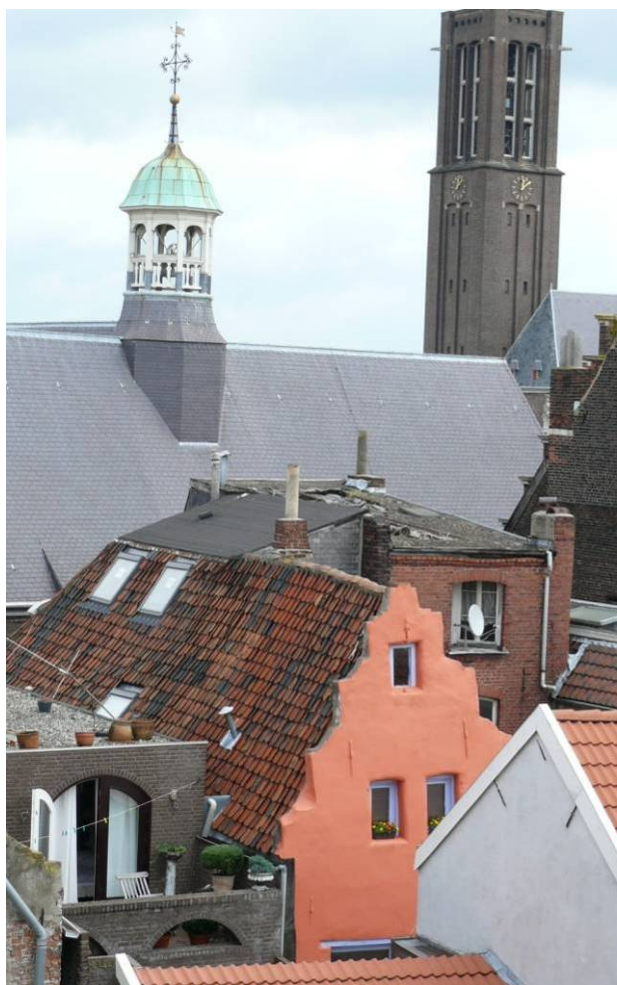
De laatmiddeleeuwse achtergevel van nr.18
