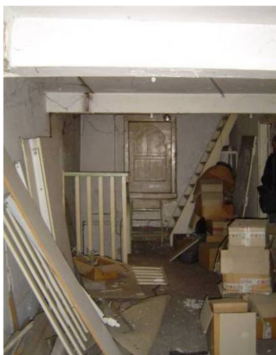
Tweede verdieping voorhuis naar achteren
