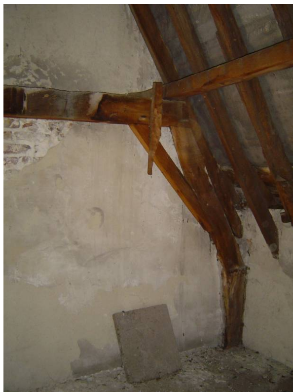
125 Zuidelijke spantbeen van het achterste strijkspant
