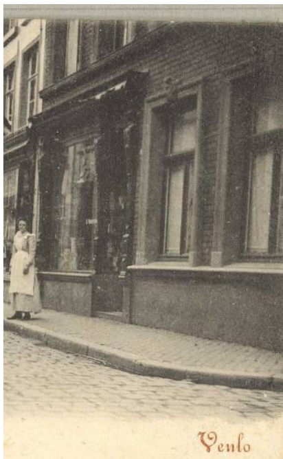
Foto ca.1900 (detail) onderpui nr.35
