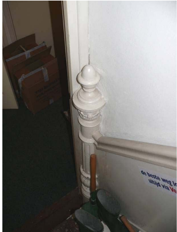
Trappaal op de eerste verdieping
