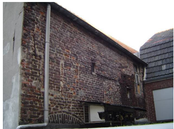
De zuidelijke zijgevel
