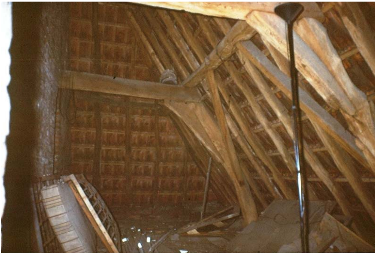
De kapconstructie van Gasthuisstraat 13 richting de voorgevel met links de deelmuur
