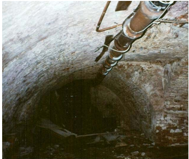
De smallere achterkelder van Gasthuisstraat 16 (1993)
