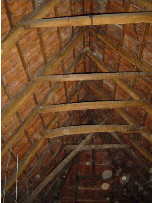
De sporenparen met haanhouten
