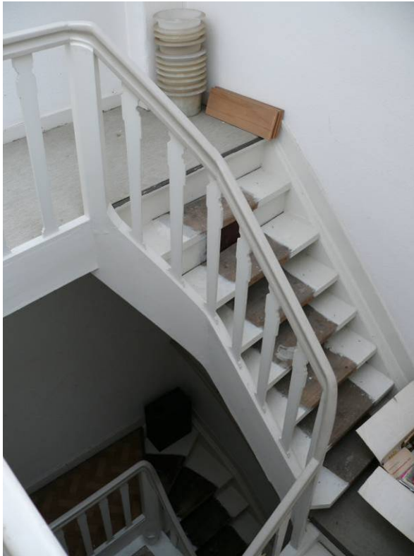
Het trappenhuis vanaf de kapverdieping naar beneden
