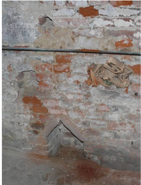
28 een kaarsnis in de voorkelder van nr.9, steekt nog net boven de verhoogde vloer uit
