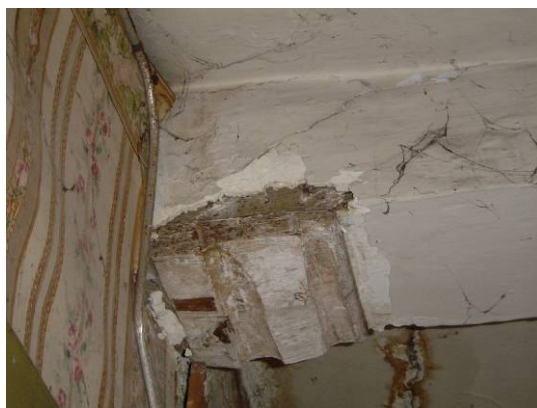
Tweede verdieping, afgekapst sleutelstuk
