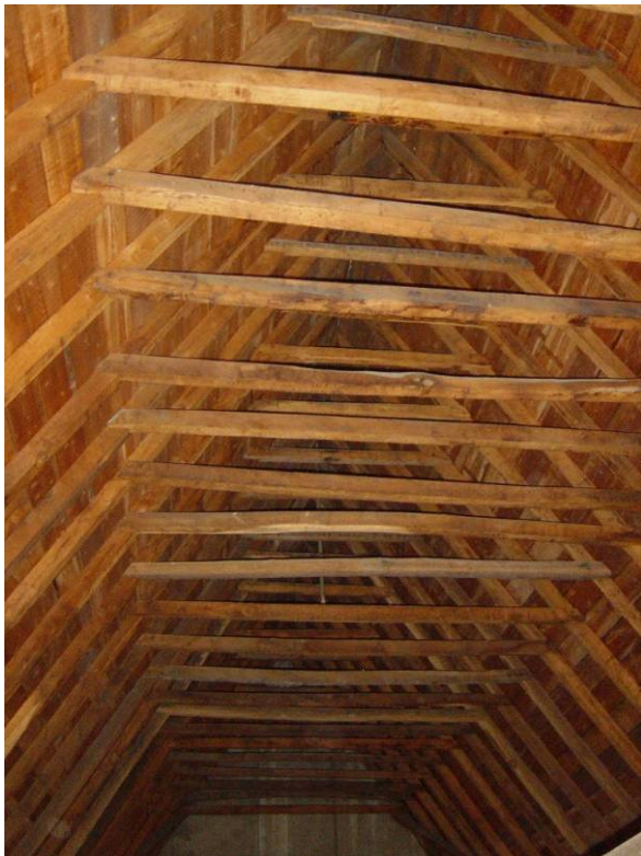
36 de daksporen en haanhouten in de kapconstructie
