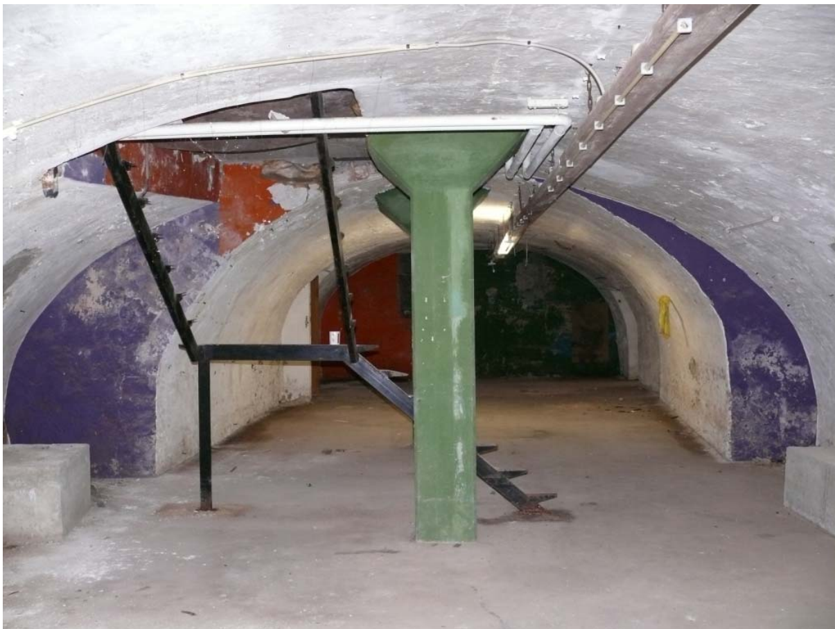
63 De kelder van Vleesstraat 13 richting achtergevel
