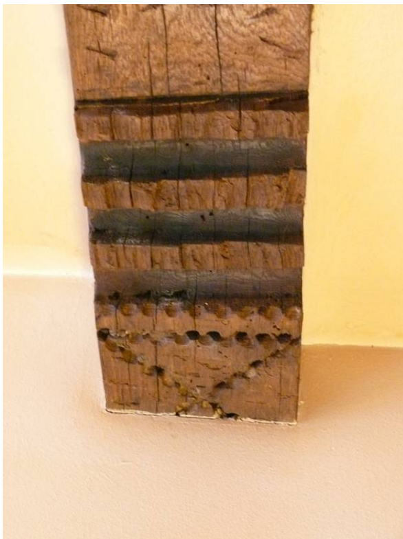
10 sleutelstuk met afgekapte rondstaafprofiel
