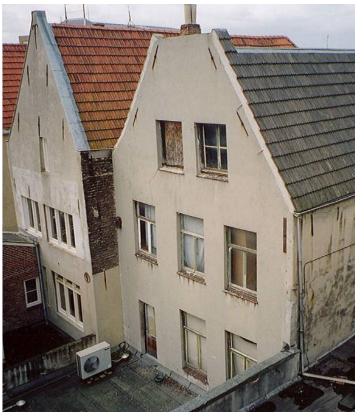
98 De achtergevel van Vleesstraat 19 (rechts)
