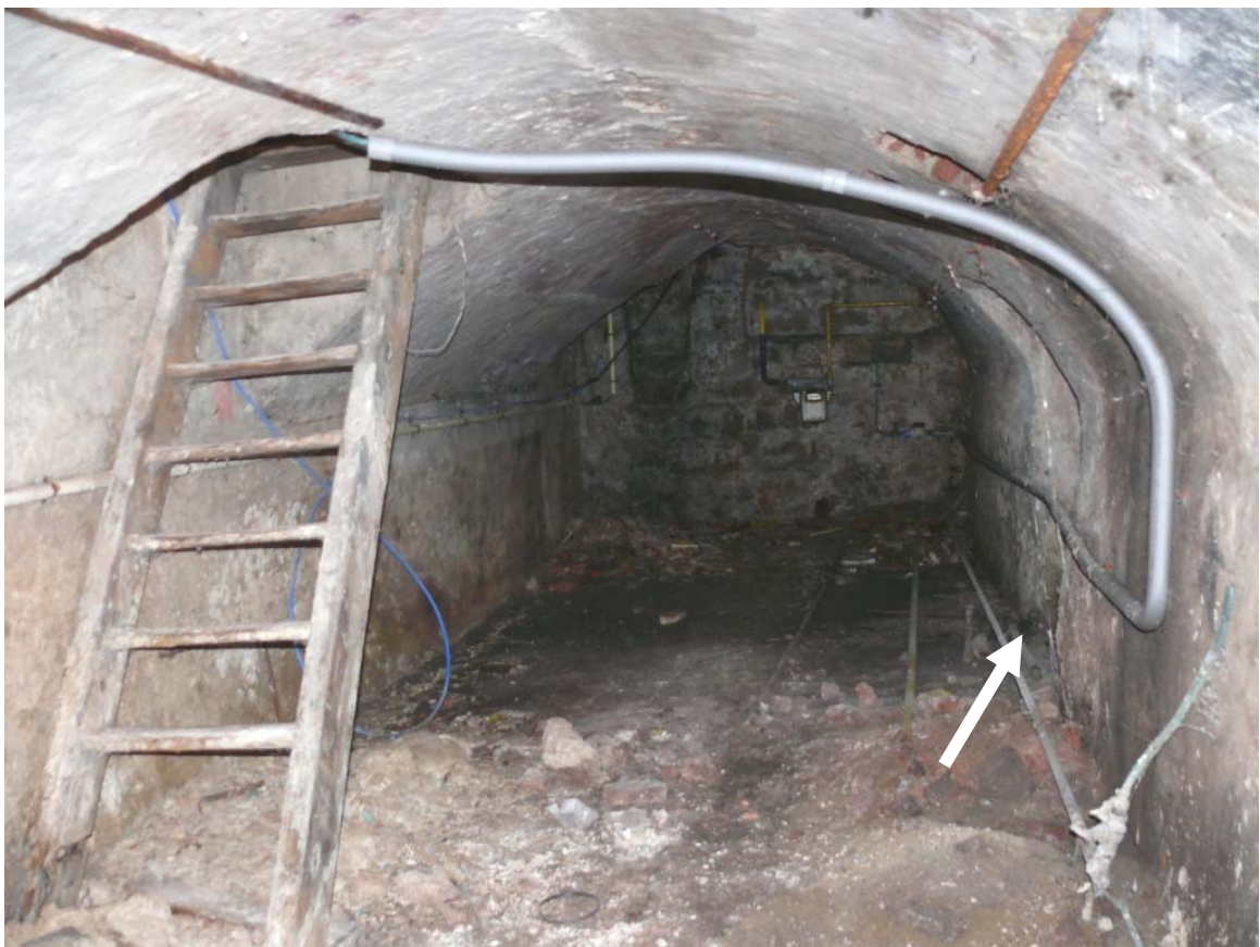
De kelder van Gasthuisstraat 11 richting de voorgevel, bij de pijl de dichtgezette doorgang naar nr.9
