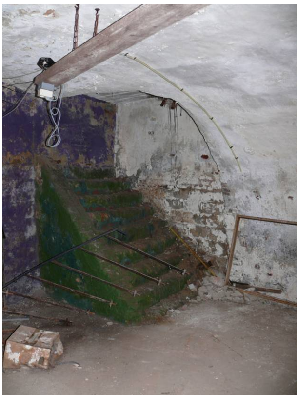
64 De oorspronkelijke kelder toegang bij de voorgevel
