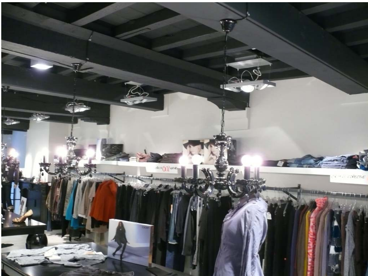
De laatmiddeleeuwse balklaag op de eerste verdieping van Gasthuisstraat 10
