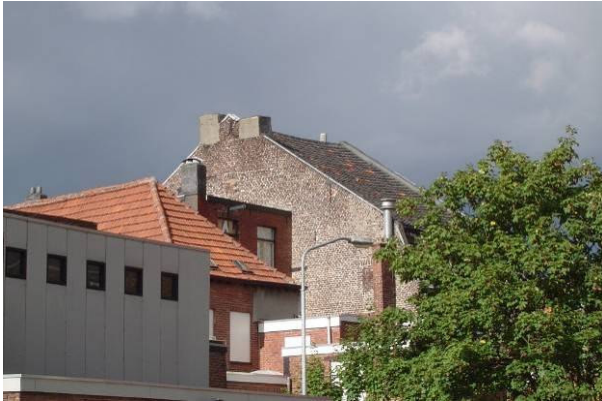
De zuidelijke zijgevel
