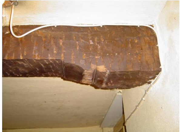
Een sleutelstuk op de eerste verdieping
