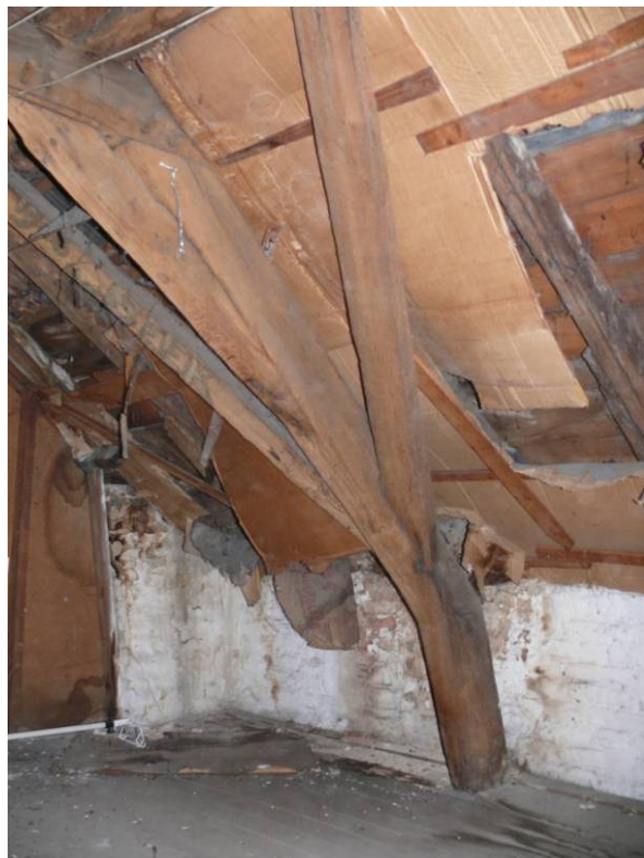
57 Het spantbeen van het halve krommerspant
