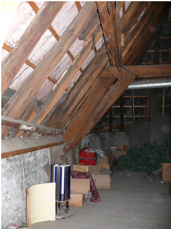
Spantbeen van het 'halve' kappant
