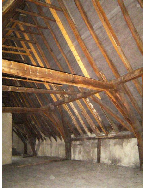
118 De eiken kapconstructie uit 1467
