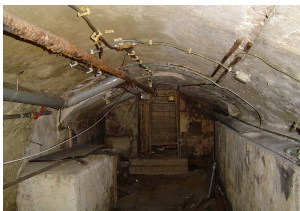
De kelder richting achtergevel
