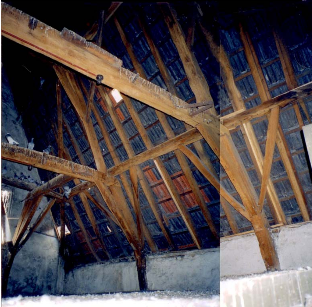
68 De laatmiddeleeuwse eiken kapconstructie met gestapelde krommerspanten, richting achterzijde
