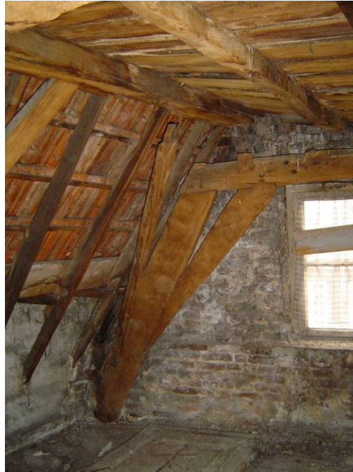
Verzakt spantbeen voorste strijkspant
