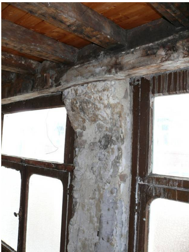
14 strijkbalk bij de voorgevel op de derde verdieping
