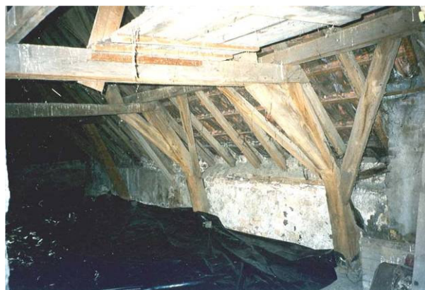
Eiken spanten van de kapconstructie
