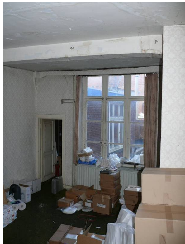
Achterkamer op de verdieping met omstucte balken
