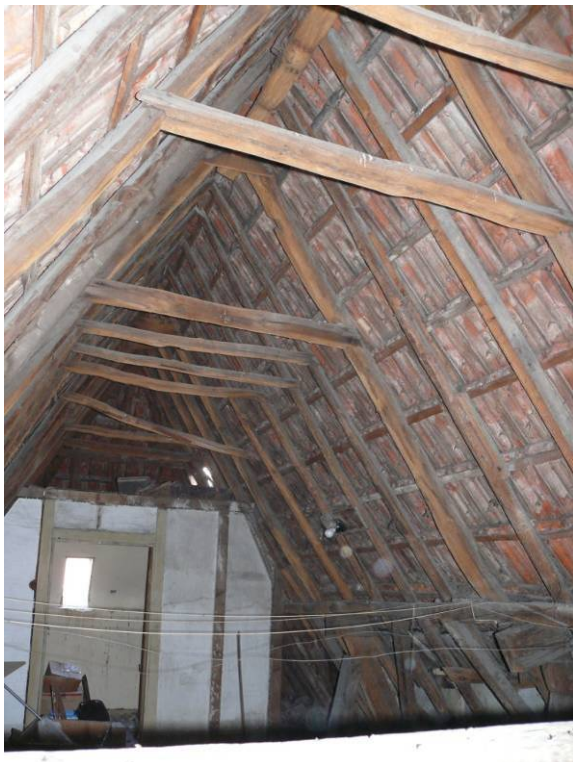
93 Eiken sporenparen met haanhouten van de kapconstructie
