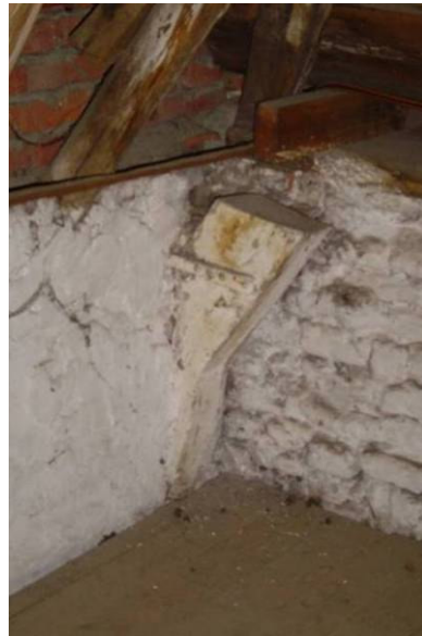
Afgezaagd strijkspant aan achterzijde
