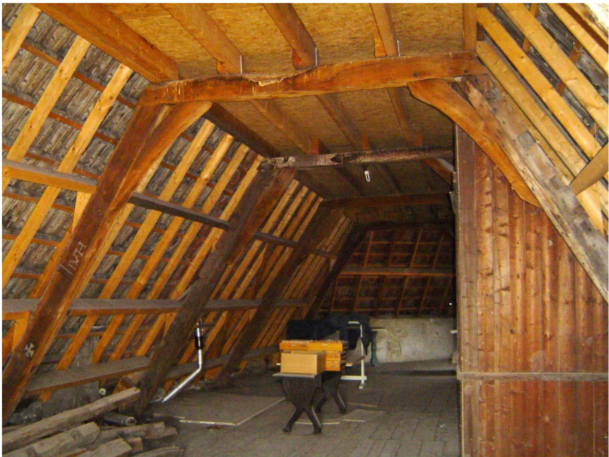
103 Overzicht van de kapconstructie richting de voorgevel
