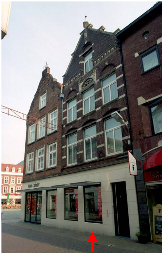
De voorgevel van Gasthuisstraat 1
