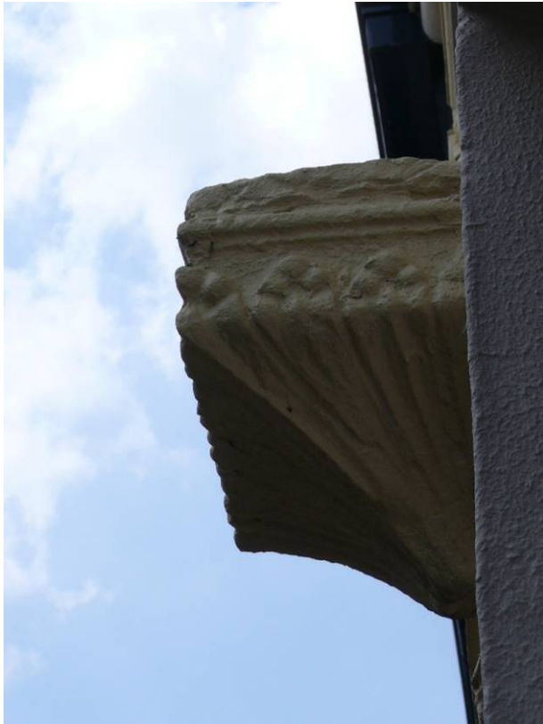
Gotische console in de voorgevel van nr.13-15
