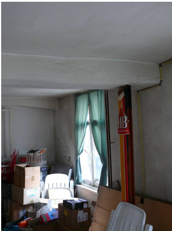
Kamer op de eerste verdieping met moerbalk
