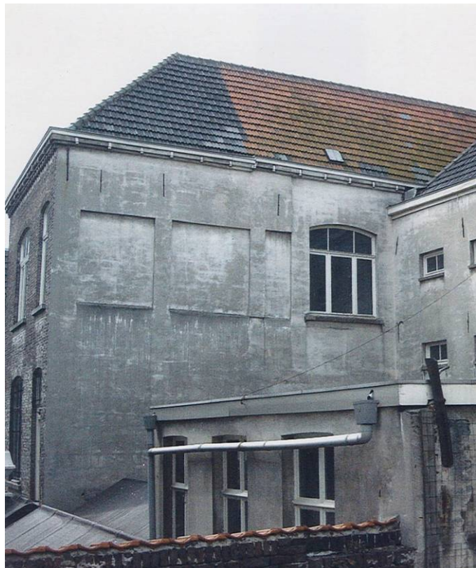
74 De noordelijke zijgevel van Vleesstraat 15
