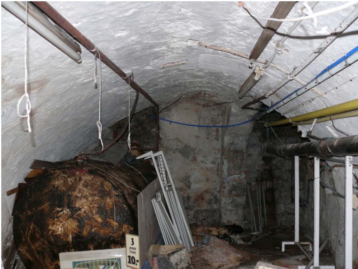
89 De laatmiddeleeuwse kelder richting de voorgevel met rechts de oorspronkelijke ingang
