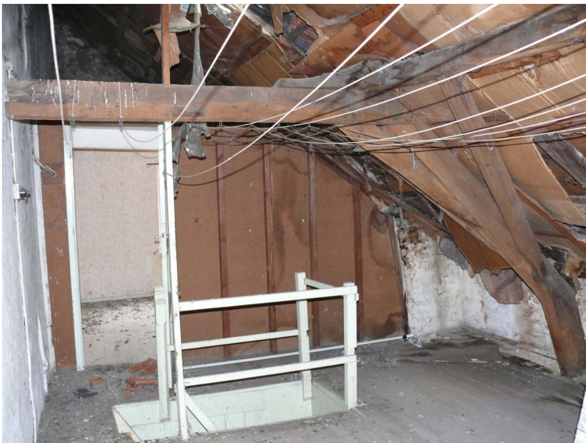
58 De zolderverdieping richting voorgevel met het halve eikenhouten krommerspant
