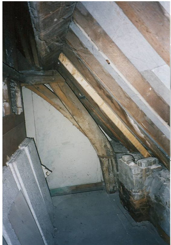
Spantbeen van een kapspant
