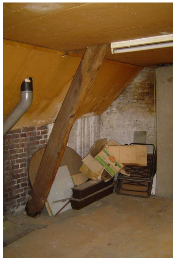
Spantbeen A-spant van kapconstructie
