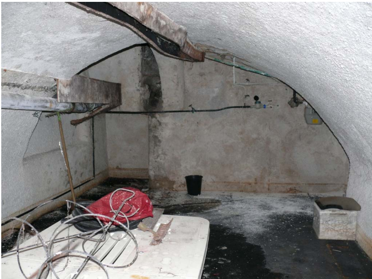
De kelder van het hoofdhuis richting de voorgevel, met links de dichtgezette, oorspronkelijke toegang
