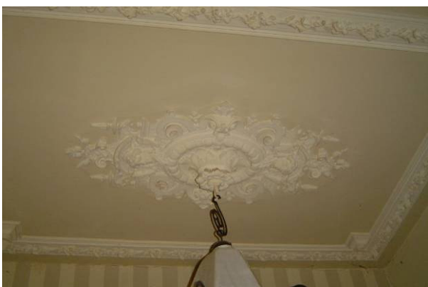
Stucplafond eerste verdieping
