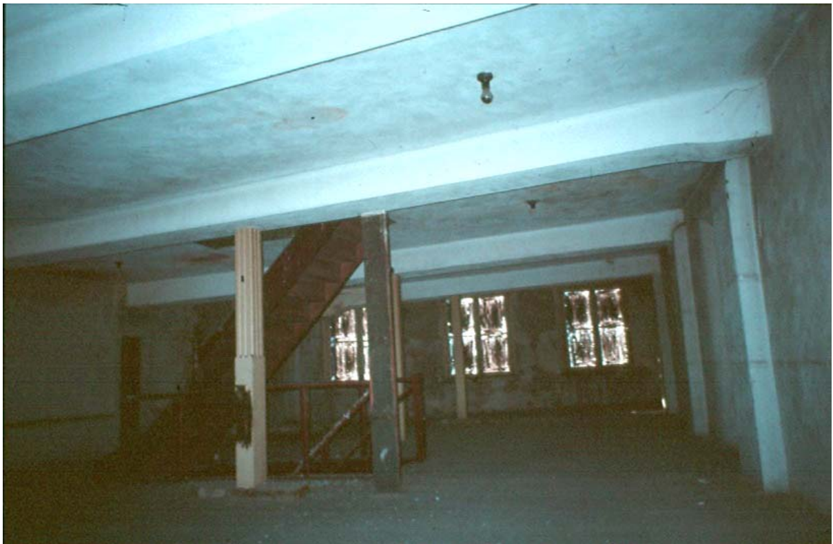
67 De balklaag op de tweede verdieping
