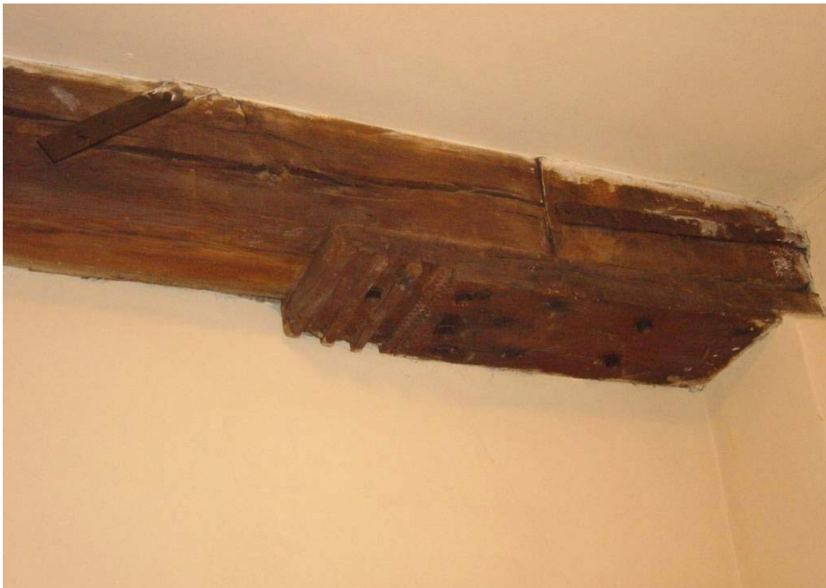
34 sleutelstuk met drievoudig rondstaafprofiel op de tweede verdieping van nr.9
