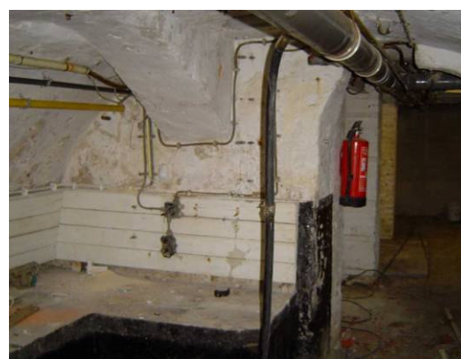
Kelder richting achtergevel
