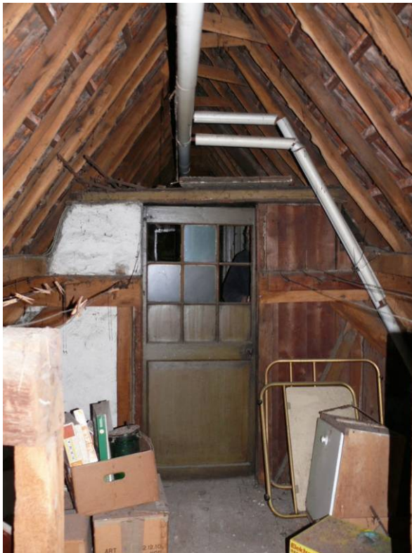
De kapconstructie vanaf de achtergevel gezien
