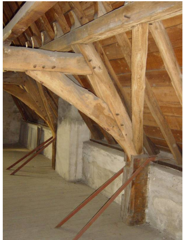
37 de spantbenen van de jucken, met herstelde voet
