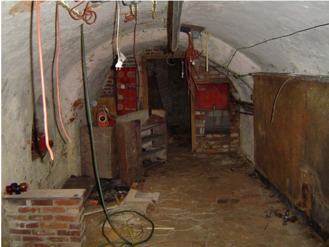
99 De noordelijke kelder van Vleesstraat 19 richting voorgevel
