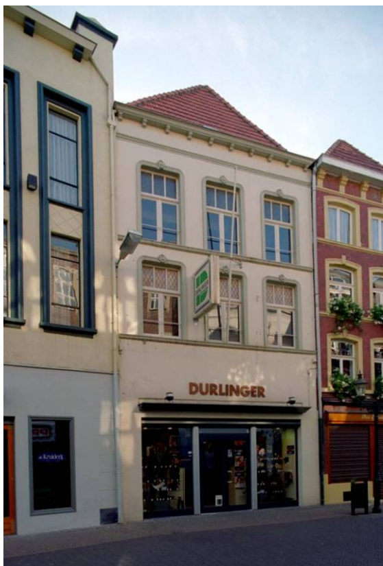
115 De voorgevel van Vleesstraat 21
