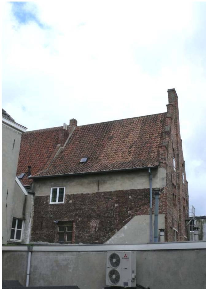
25 de zuidelijke zijgevel
