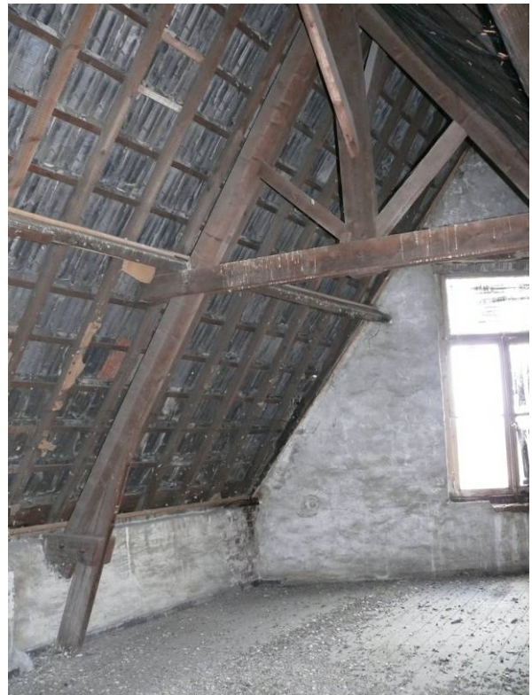
81 Het voorste grenen spant (XIXd) van de kapconstructie
