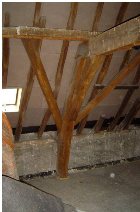
Krommer van eiken kapspanten
