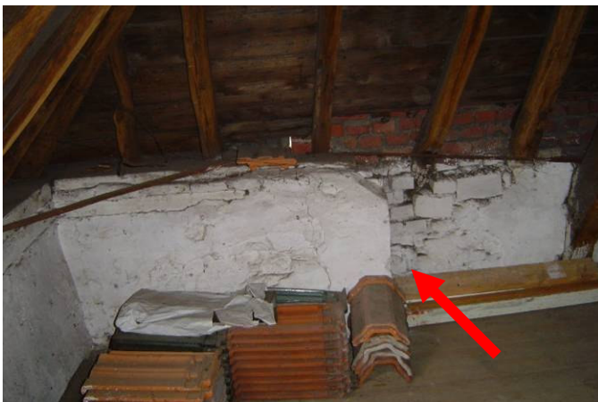
Verspringing in zuidelijke zijgevel
