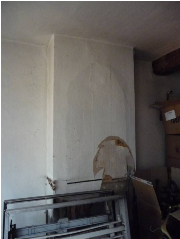
Rookkanaal met dichtgezette kachelnis op de 1 e verdieping
