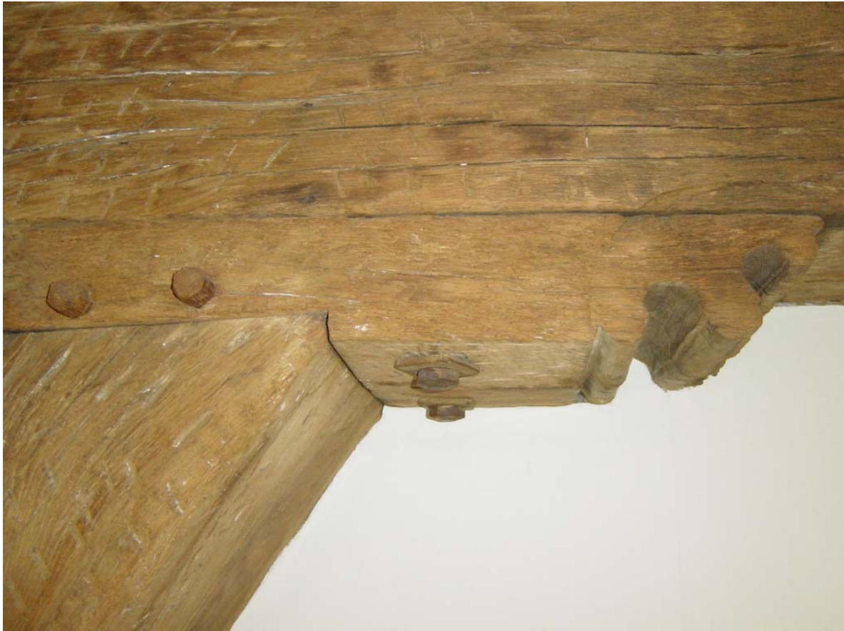
33 laatmiddeleeuws sleutelstuk met peerkraalprofiel in achterhuis van nr.7
