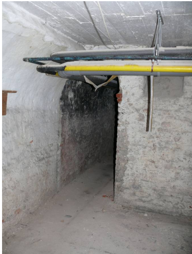
51 de bakstenen kelder, waarvan het gewelf in beton is vervangen
