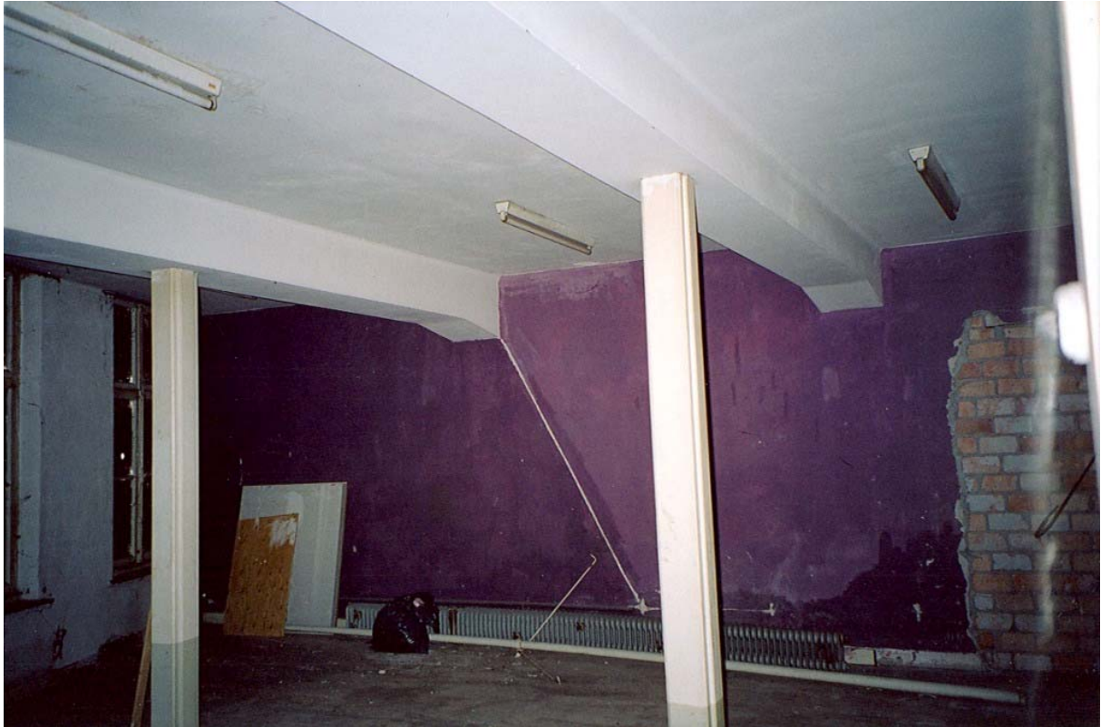
66 De balklaag op de eerste verdieping
