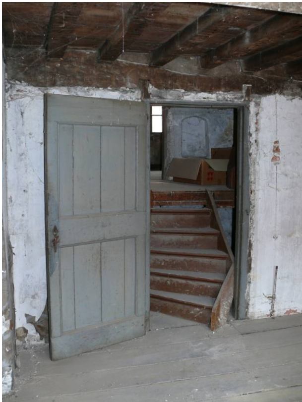
12 voorkamer van de derde verdieping, naar achteren
