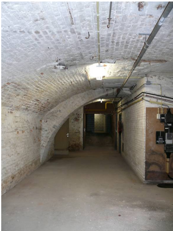
76 De bakstenen gordelboog halverwege de kelder
